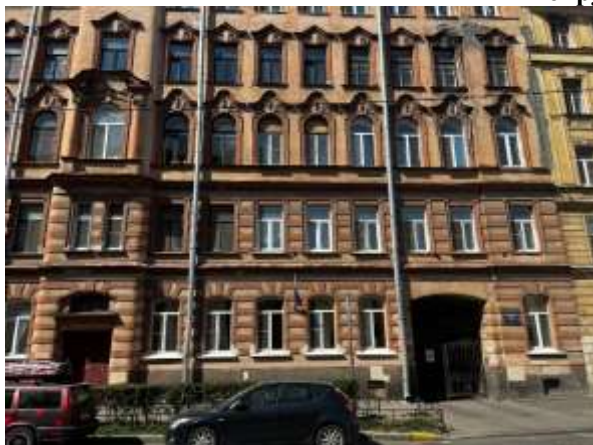
Фото 1. Вид здания Объекта оценки с улицы
