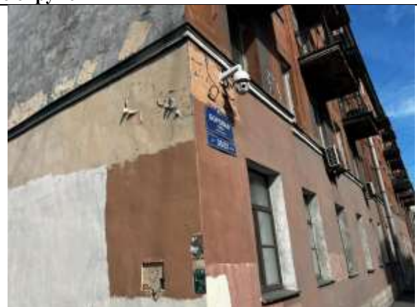
Фото 2. Вид здания, в котором расположен Объект оценки, Табличка с номером дома
