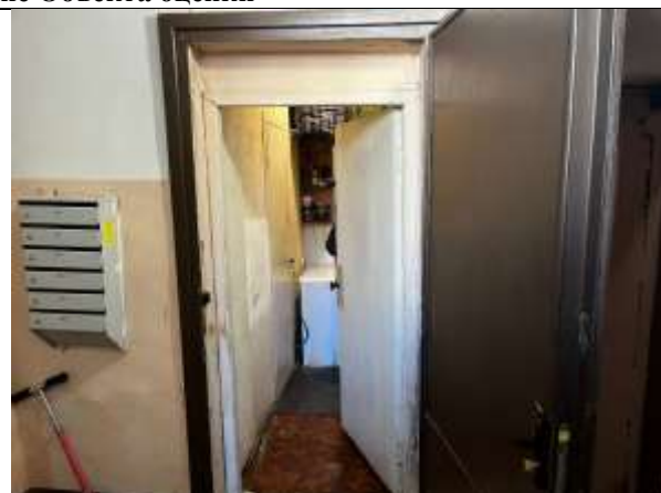
Фото 8. Внутреннее состояние Объекта оценки
