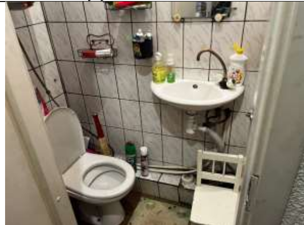
Фото 12. Внутреннее состояние Объекта оценки
