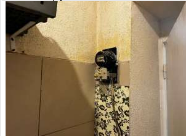
Фото 11. Внутреннее состояние Объекта оценки
