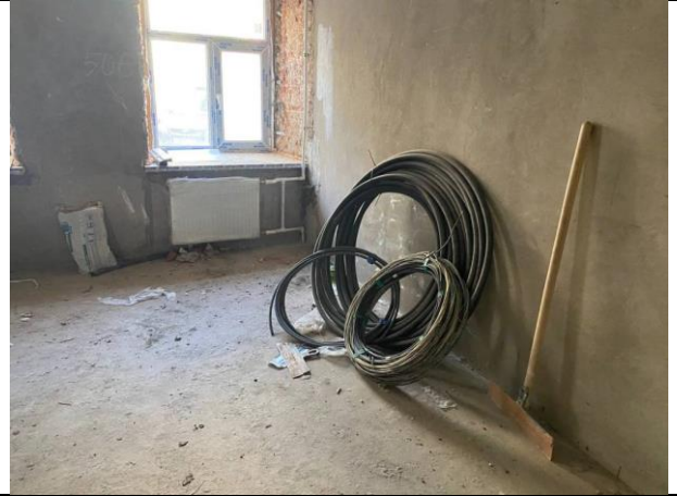
Фото № 16 – Внутреннее состояние помещения
