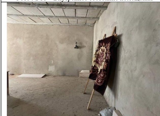
Фото № 13 – Внутреннее состояние помещения
