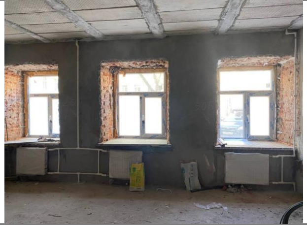
Фото № 18 – Внутреннее состояние помещения
