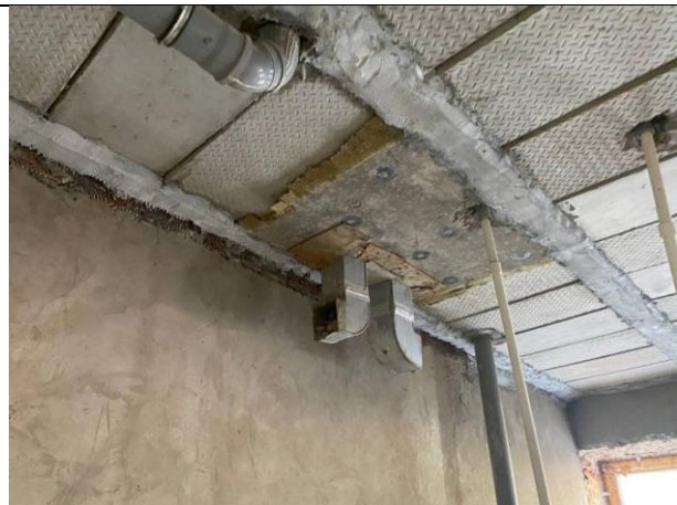
Фото № 8 – Внутреннее состояние помещения
