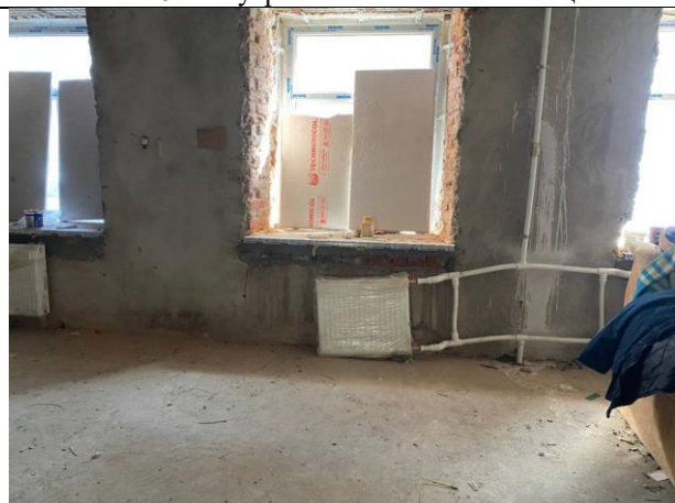
Фото № 10 – Внутреннее состояние помещения
