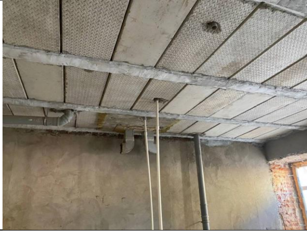
Фото № 17 – Внутреннее состояние помещения
