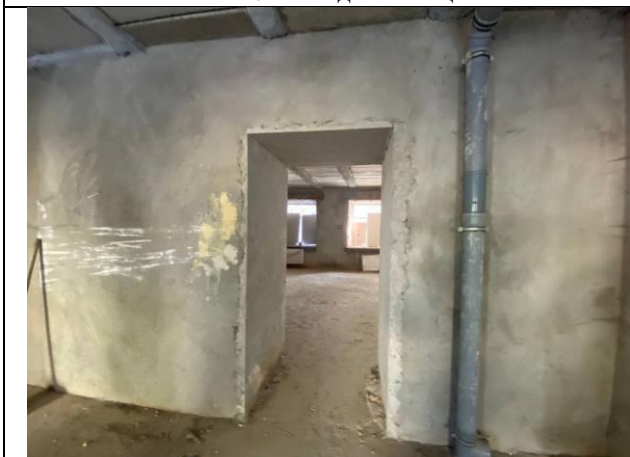
Фото № 9 – Внутреннее состояние помещения
