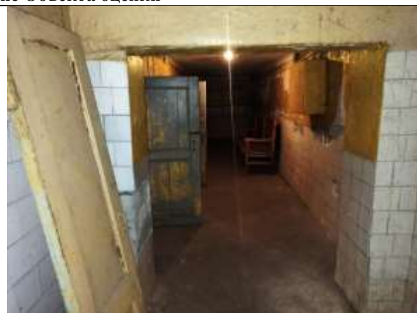
Фото 12. Внутреннее состояние Объекта оценки
