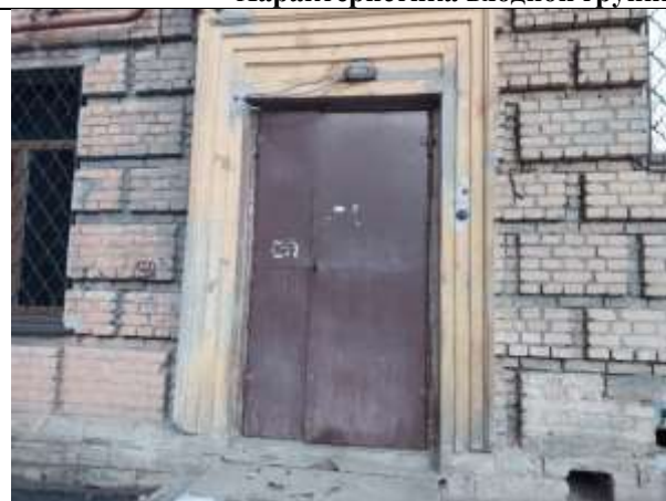
Фото 9. Общий вход Объекта оценки со двора
