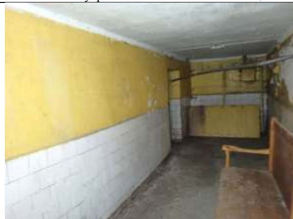
Фото 14. Внутреннее состояние Объекта оценки
