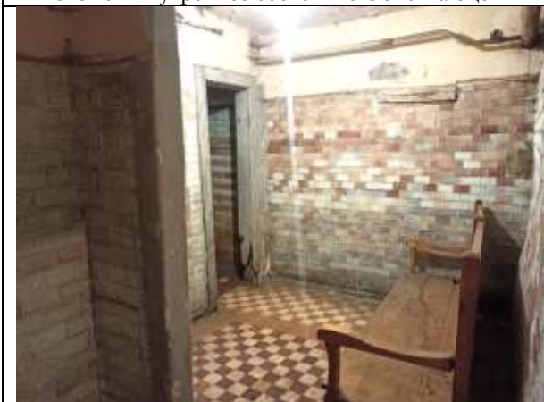
Фото 21. Внутреннее состояние Объекта оценки
