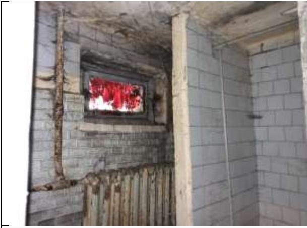
Фото 15. Внутреннее состояние Объекта оценки
