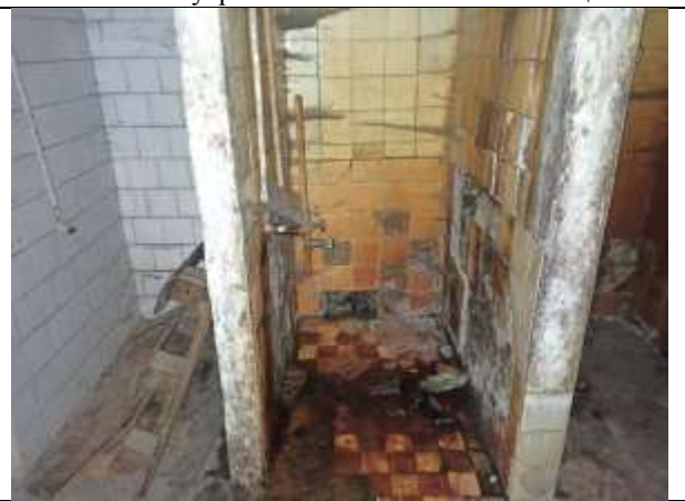
Фото 18. Внутреннее состояние Объекта оценки
