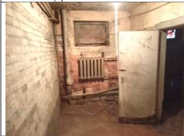
Фото 17. Внутреннее состояние Объекта оценки
