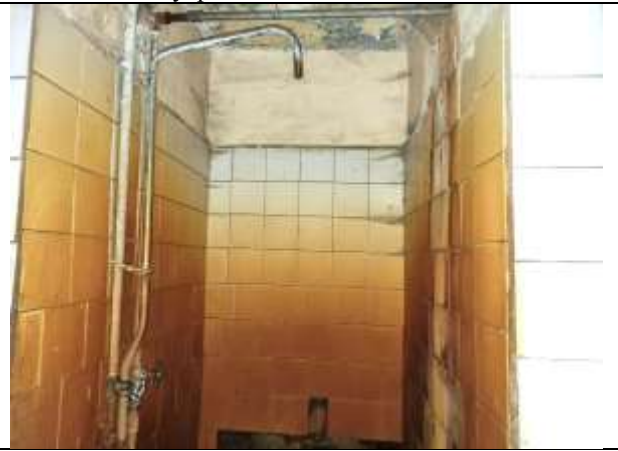
Фото 20. Внутреннее состояние Объекта оценки
