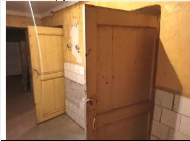
Фото 19. Внутреннее состояние Объекта оценки
