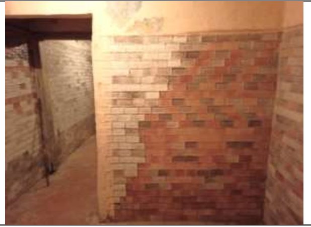
Фото 16. Внутреннее состояние Объекта оценки
