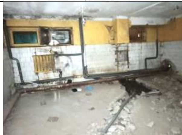
Фото 13. Внутреннее состояние Объекта оценки
