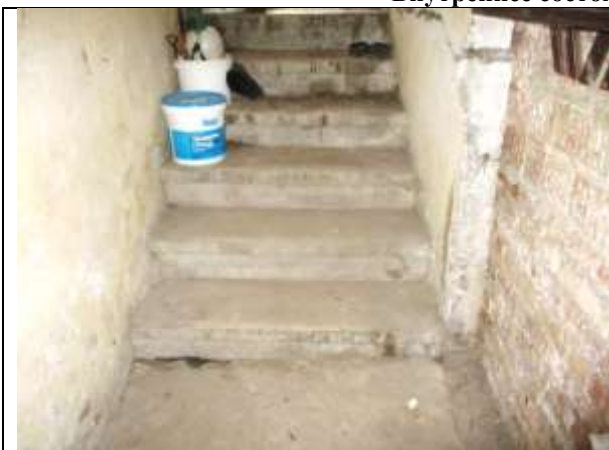
Фото 7. Внутреннее состояние Объекта оценки
