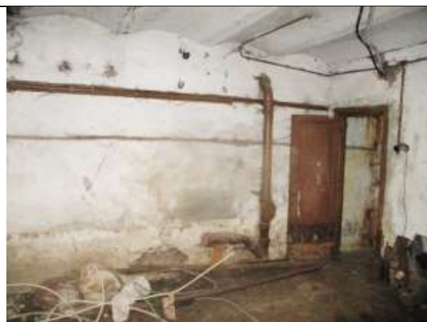
Фото 12. Внутреннее состояние Объекта оценки
