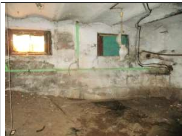
Фото 11. Внутреннее состояние Объекта оценки
