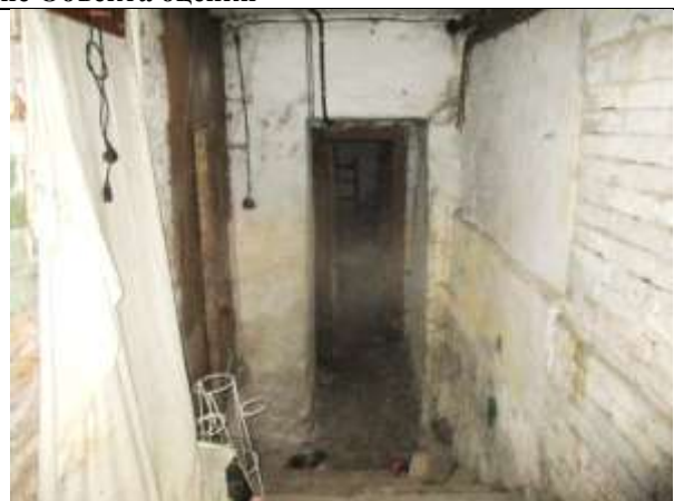
Фото 8. Внутреннее состояние Объекта оценки
