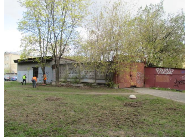
Фото № 1. Подъездные пути и окружение объекта
