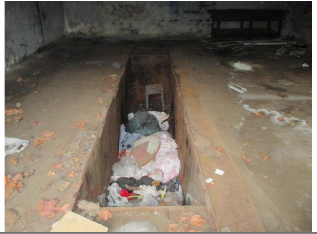
Фото № 10. Внутреннее состояние помещения
