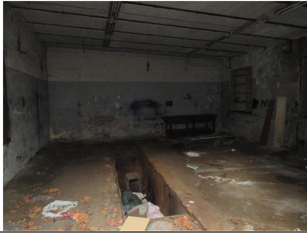
Фото № 9. Внутреннее состояние помещения
