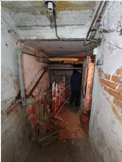
Фото № 13 – Внутреннее состояние помещения
