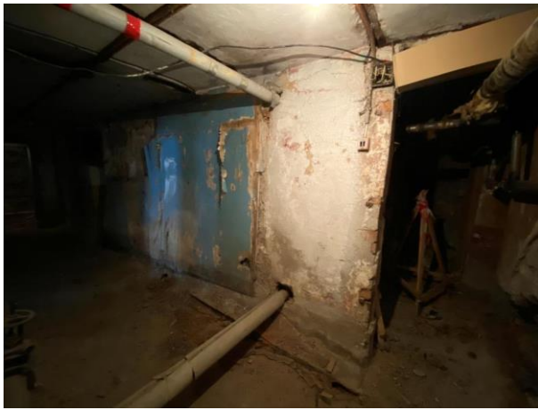
Фото № 17 – Внутреннее состояние помещения
