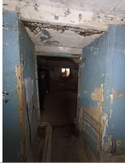
Фото № 12 – Внутреннее состояние помещения
