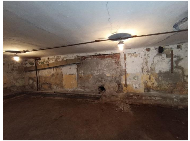
Фото № 10 – Внутреннее состояние помещения
