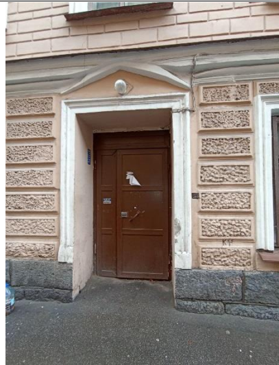
Фото № 4 – Вход в помещение (общий с улицы)
