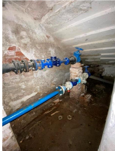
Фото № 16 – Внутреннее состояние помещения
