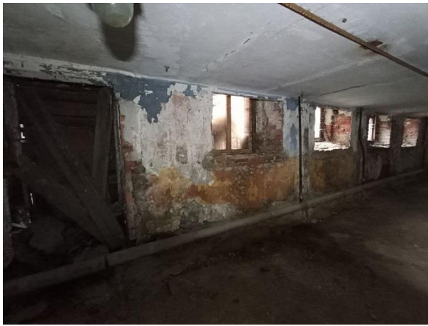
Фото № 11 – Внутреннее состояние помещения
