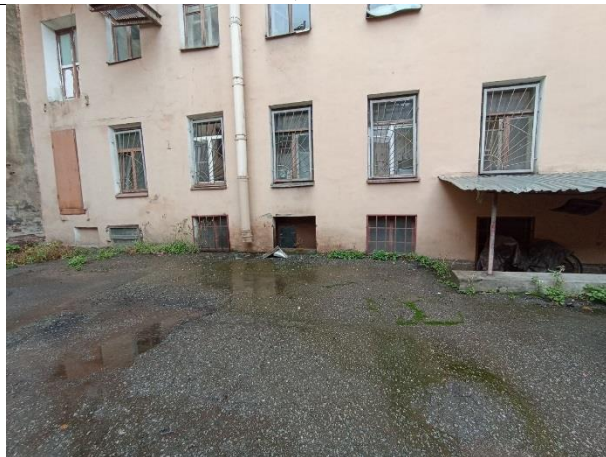
Фото № 7 – Окна в помещении
