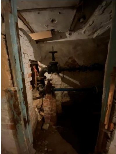
Фото № 15 – Внутреннее состояние помещения
