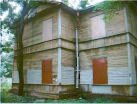
Фото 5. Восточный фасад. Общий вид.
