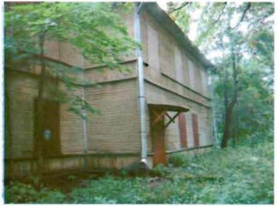
Фото 4. Западный фасад. Фрагмент.
