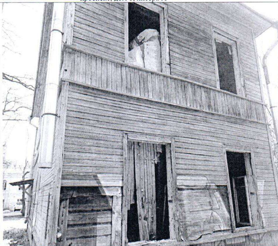
Описание: Вид на Объект
