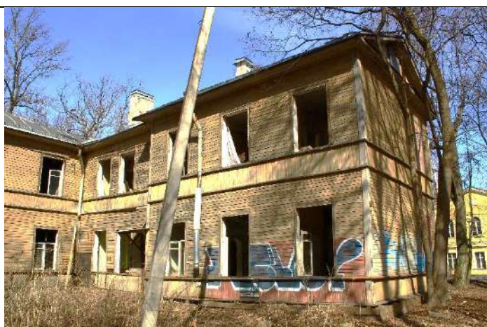
Фото № 5. Вид на фрагмент Южного фасада
