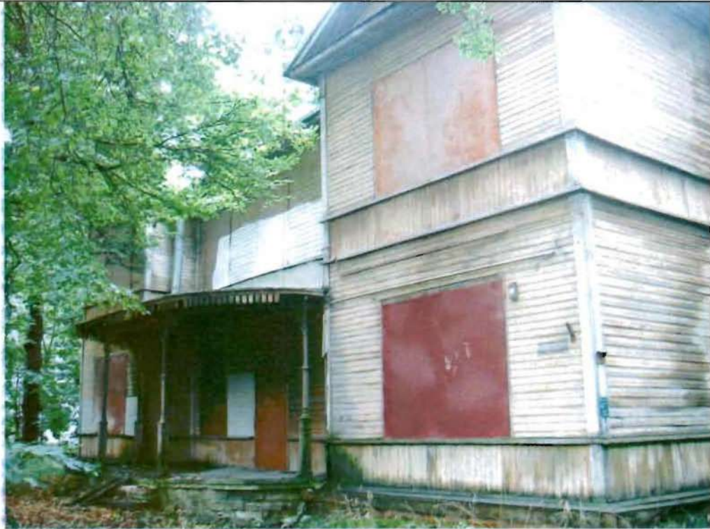
Фото 1. Северный фасад. Общий вид.
