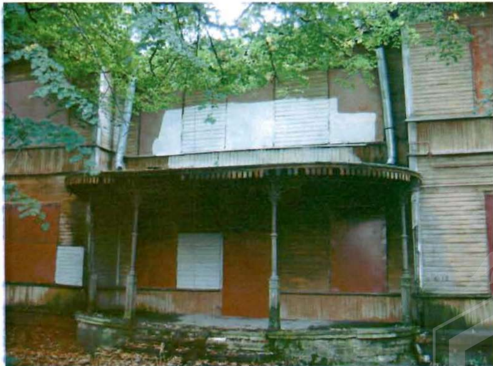
Фото 2. Северный фасад. Терраса-крыльцо. Общий вид.
