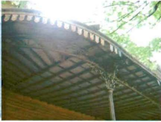
Фото 3. Северный фасад. Навес террасы-крыльца. Фрагмент.
