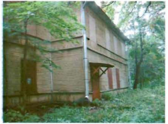
Фото 4. Западный фасад. Фрагмент.
