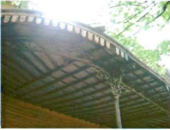
Фото 3. Северный фасад. Навес террасы-крыльца. Фрагмент.
