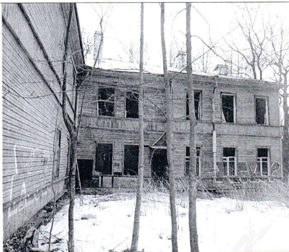
Описание: Вид на Объект
