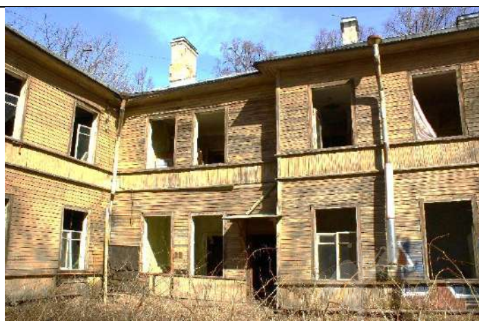
Фото № 6. Вид на фрагмент Южного фасада
