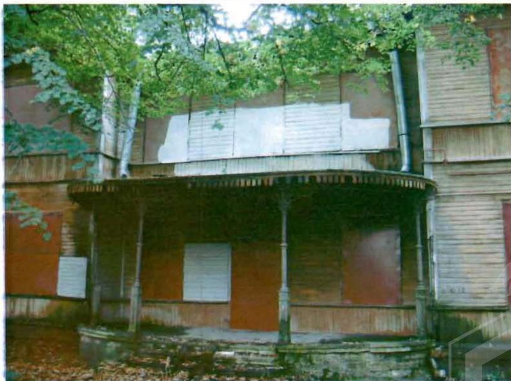
Фото 2. Северный фасад. Терраса-крыльцо. Общий вид.
