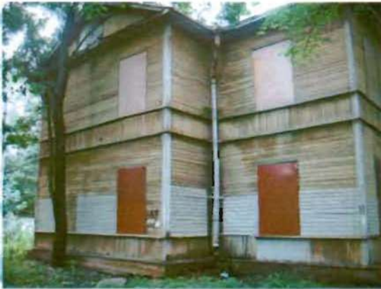
Фото 5. Восточный фасад. Общий вид.
