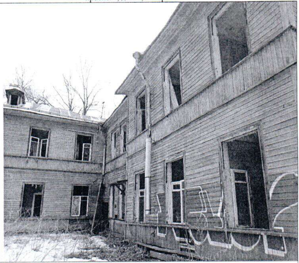
Описание: Вид на Объект
