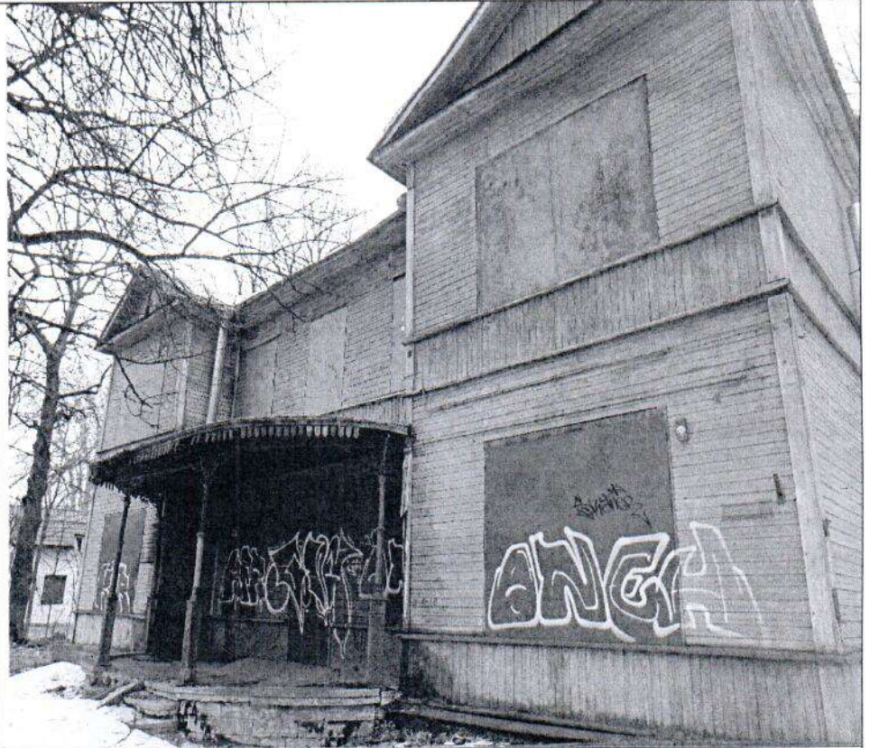
Описание: Вид на Объект
