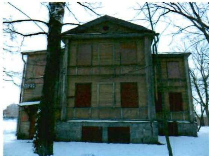
7. Северный фасад здания
