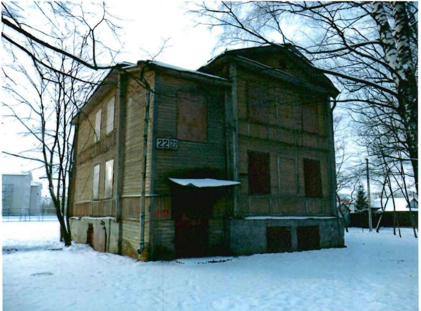
1. Северный фасад здания
