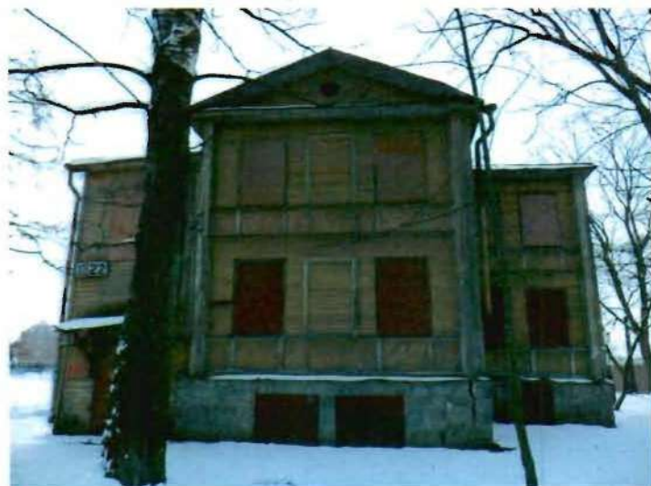
7. Северный фасад здания
