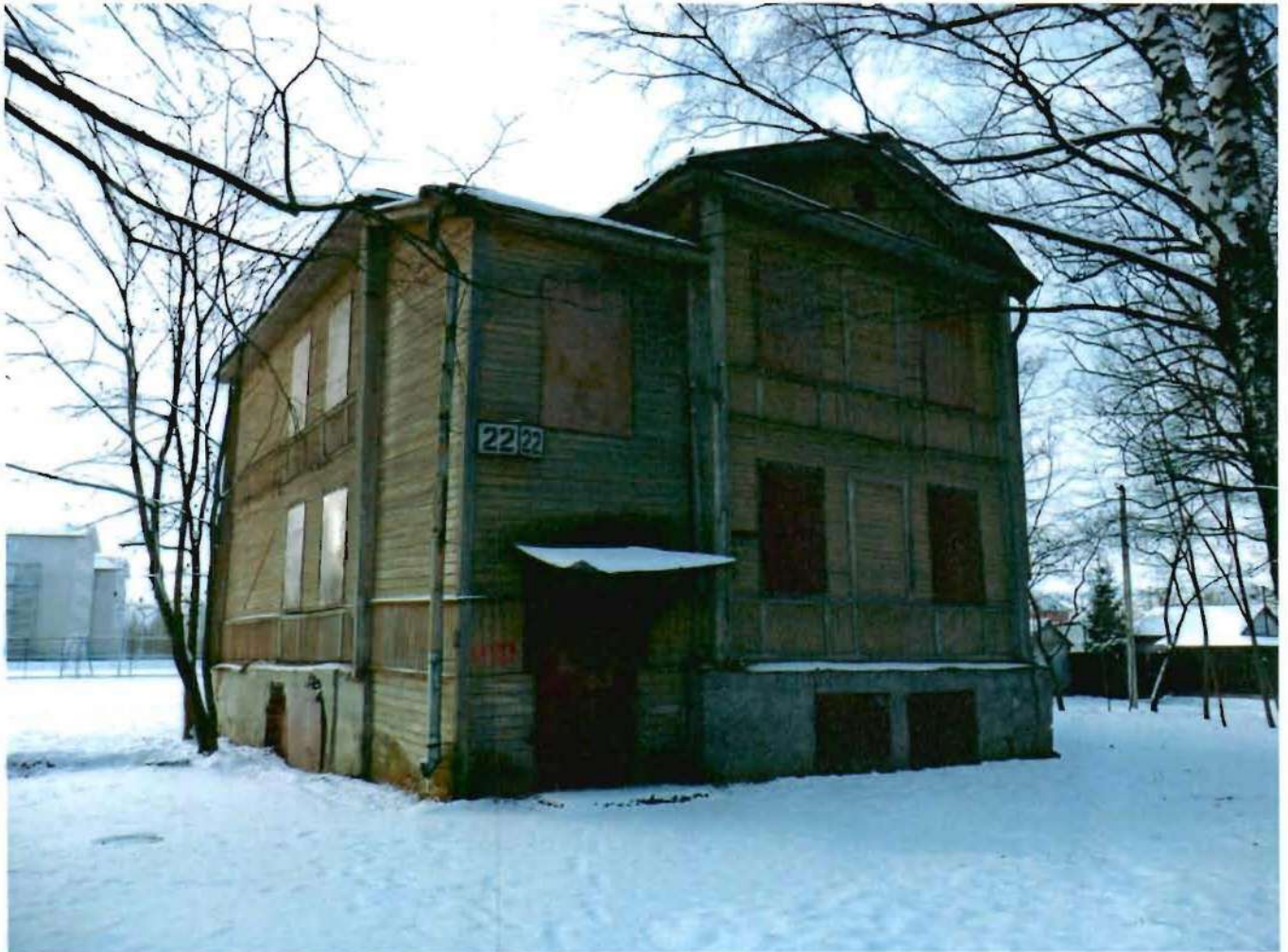
1. Северный фасад здания
