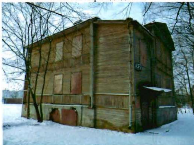
2. Восточный фасад здания
