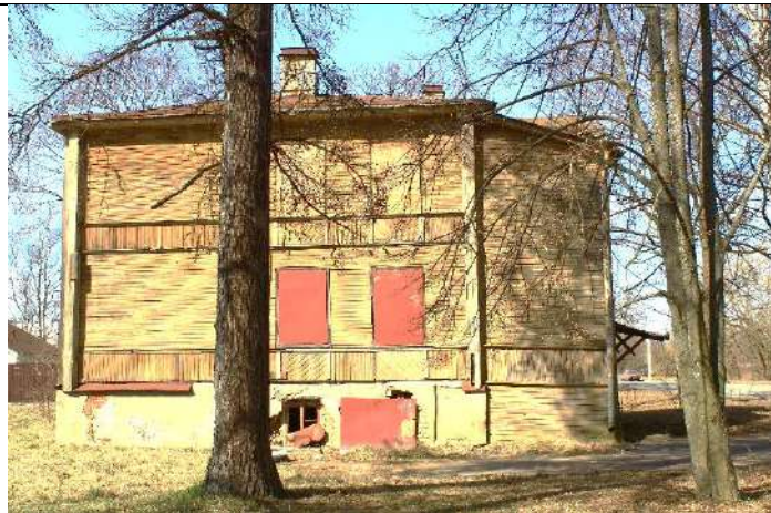
Фото № 5. Вид на Восточный фасад
