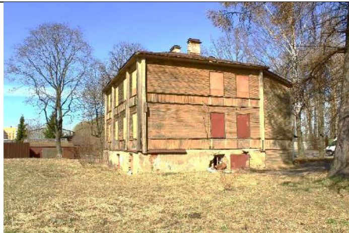
Фото № 6. Вид на Восточный фасад
