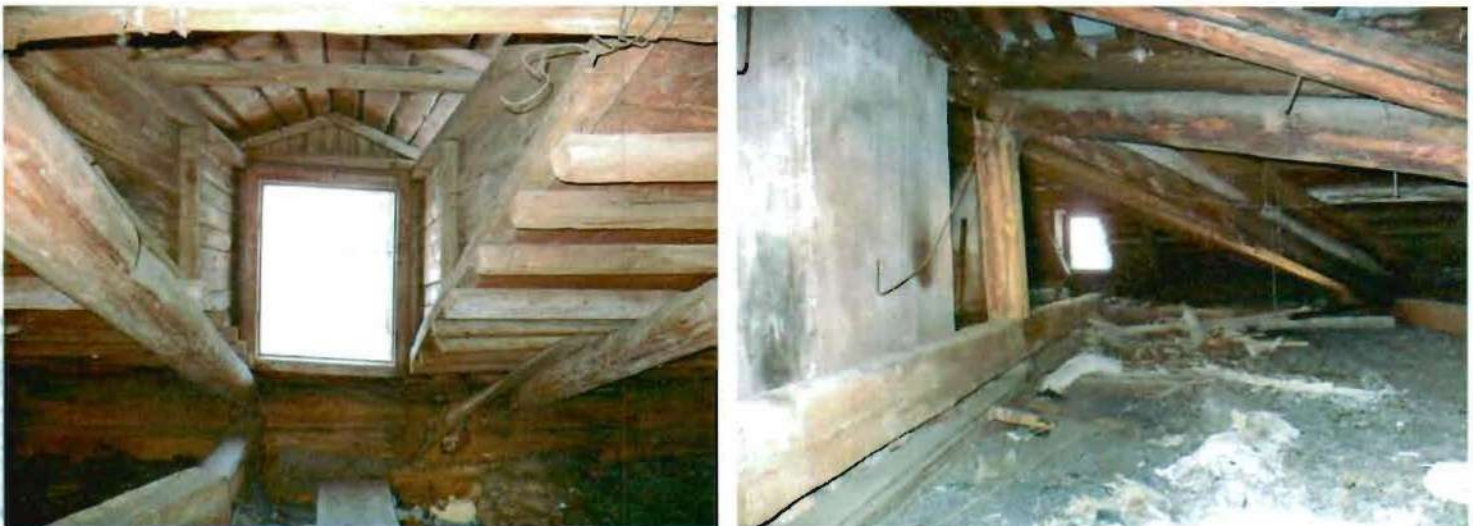
19,20. Стропильная система кровли
