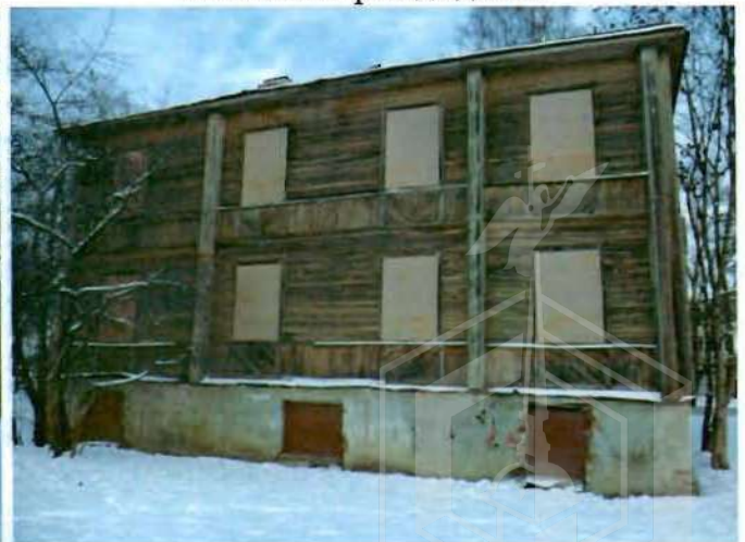
3. Южный фасад здания
