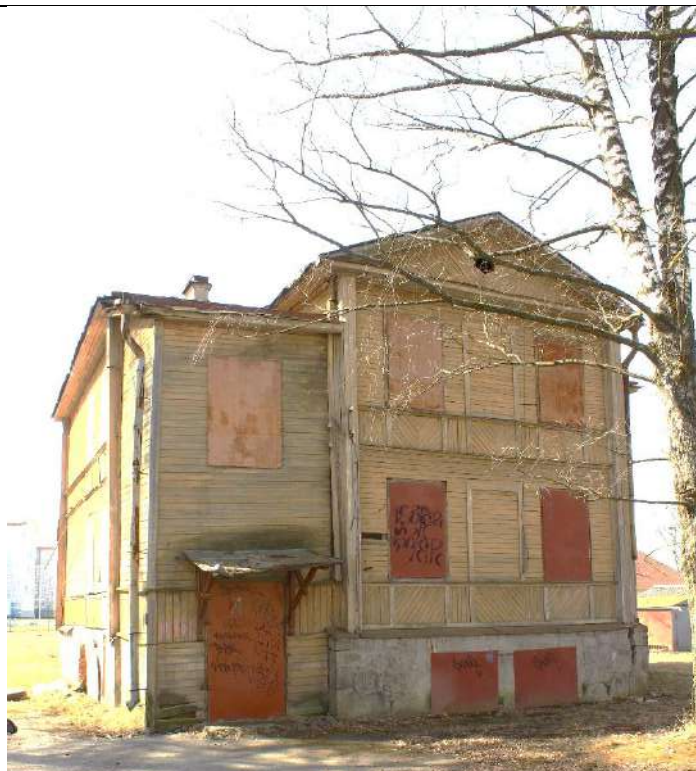
Фото № 1. Вид на Северный фасад с Собственного проспекта
