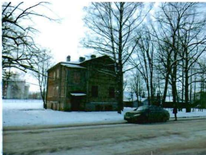
8. Общий вид на территорию объекта
