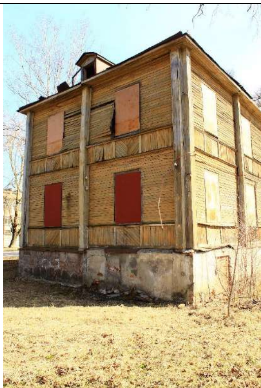
Фото № 3. Вид на Западный фасад
