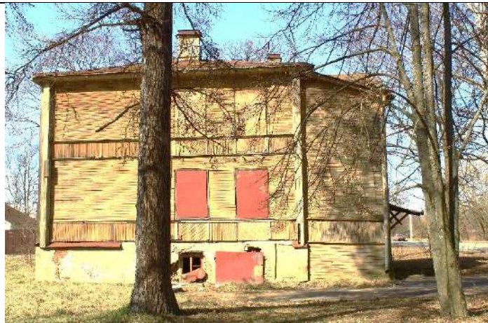
Фото № 5. Вид на Восточный фасад
