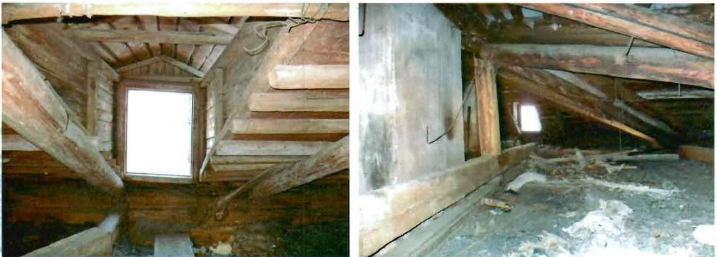
19,20. Стропильная система кровли
