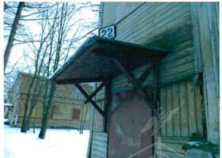
22. Козырек на деревянных кронштейнах входной зоны
