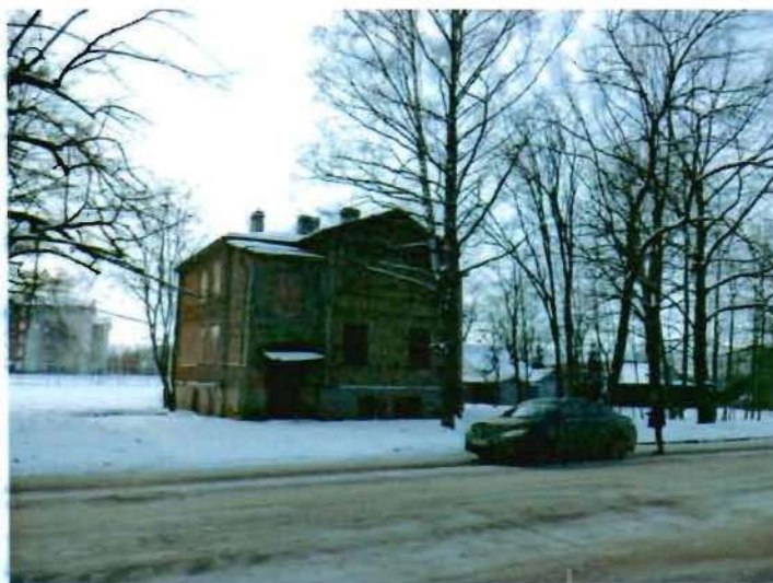
8. Общий вид на территорию объекта
