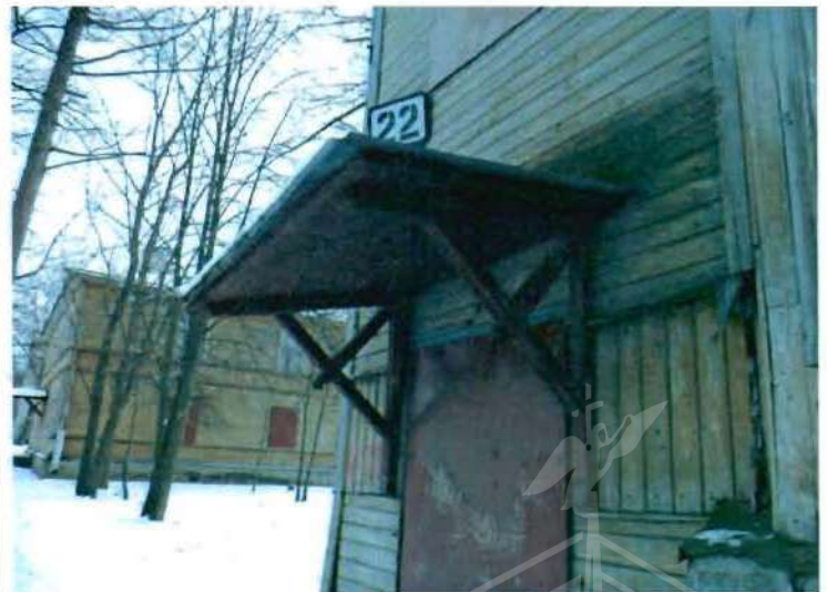
22. Козырек на деревянных кронштейнах входной зоны
