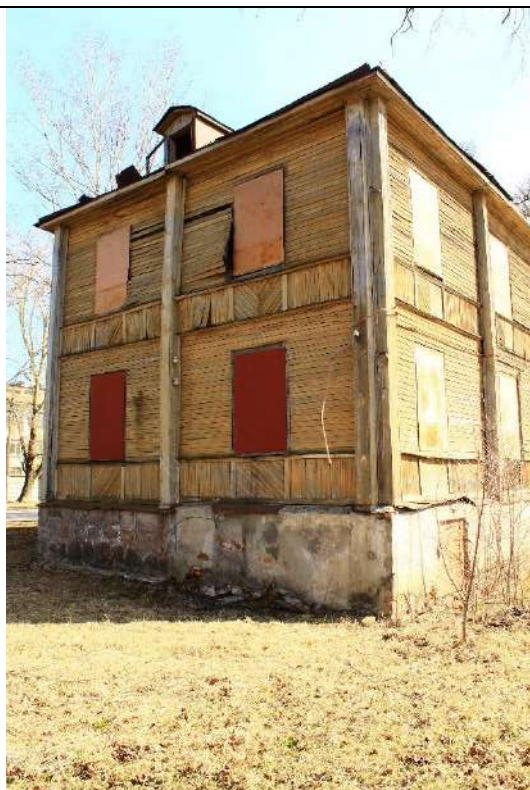
Фото № 3. Вид на Западный фасад
