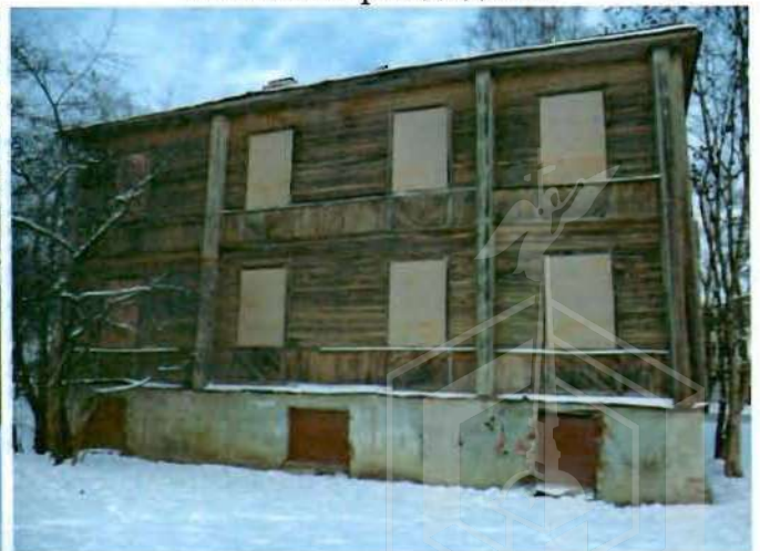
3. Южный фасад здания
