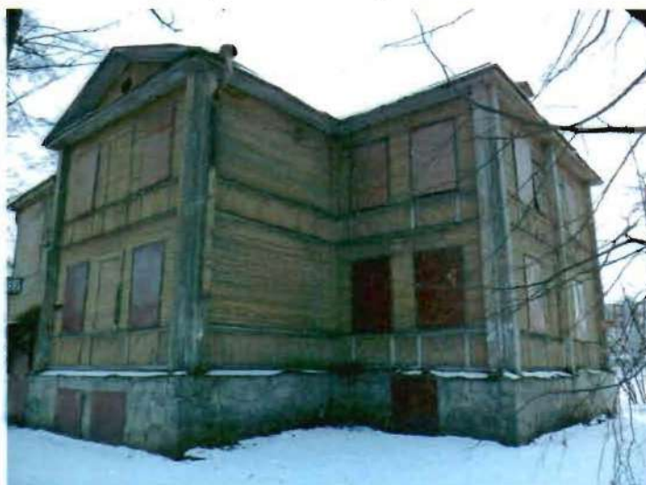
6. Северо-западный фасад здания
