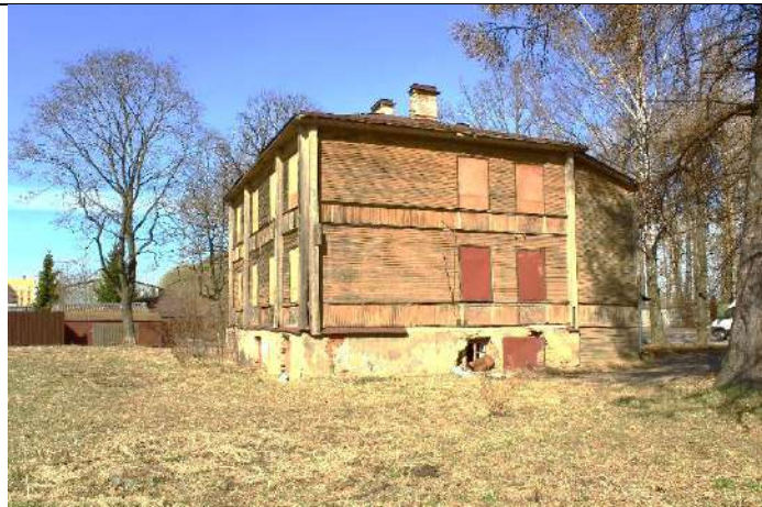
Фото № 6. Вид на Восточный фасад
