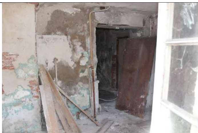
Фото № 8. Вид через оконный проем подвала на Восточном фасаде
