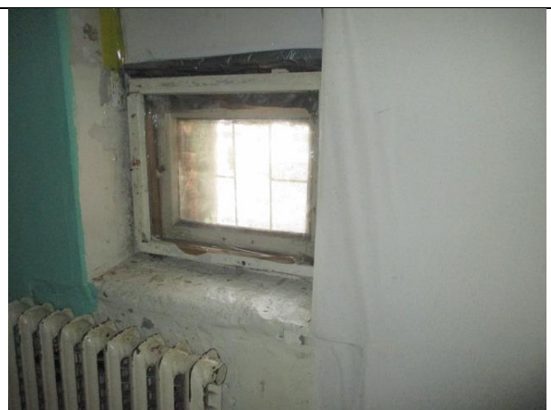
Фото 10. Внутреннее состояние Объекта оценки
