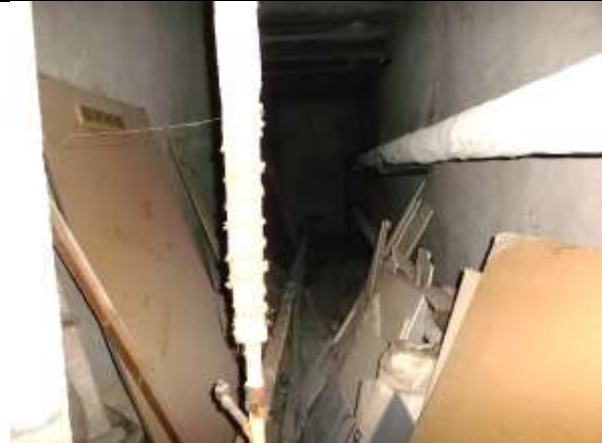
Фото 11. Внутреннее состояние Объекта оценки (пробит проход в соседнее пом. б/н)
