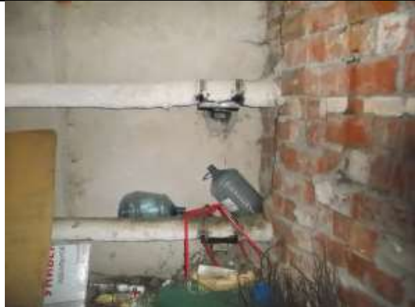
Фото 12. Внутреннее состояние Объекта оценки
