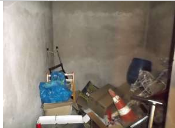
Фото 9. Внутреннее состояние Объекта оценки
