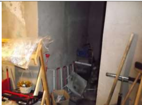
Фото 8. Внутреннее состояние Объекта оценки
