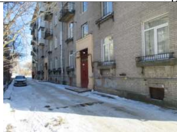
Фото 1. Вид здания, в котором расположен Объект оценки. Дворовая территория
