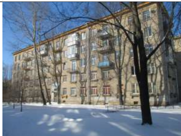
Фото 2. Вид здания, в котором расположен Объект оценки
