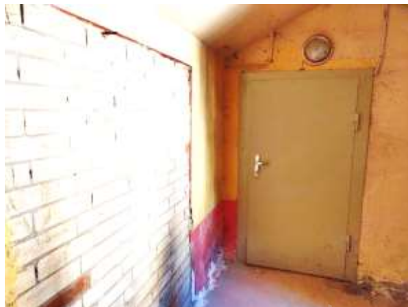
Фото 6. Вход Объекта оценки
