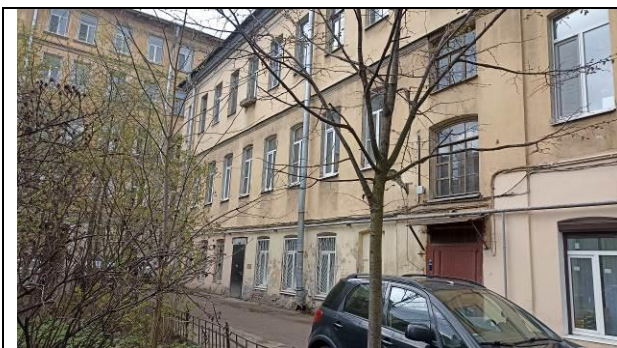
Фото 17. Вид здания расположения Объекта оценки
