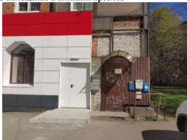
Фото 6. Общий вход с улицы
