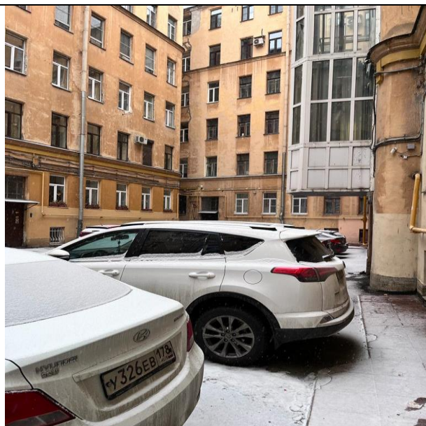
Фото 16. Внутри дворовая территория Объекта оценки
