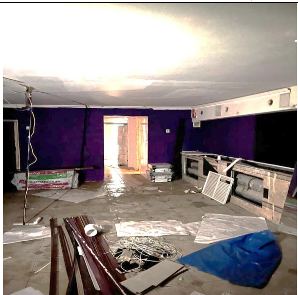
Фото 24. Типичное состояние Объекта оценки
