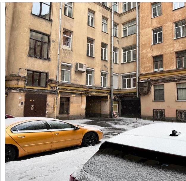
Фото 15. Внутри дворовая территория Объекта оценки
