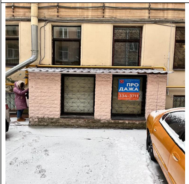
Фото 17. Вид здания расположения Объекта оценки
