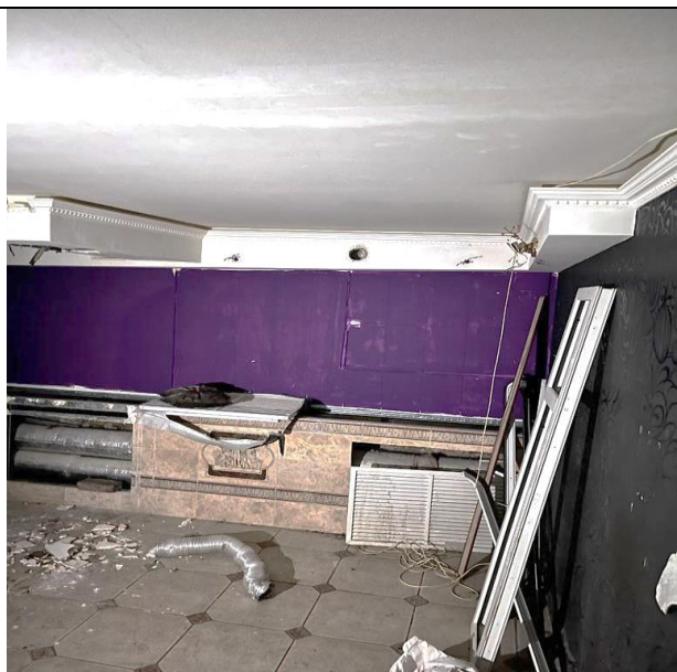
Фото 22. Типичное состояние Объекта оценки
