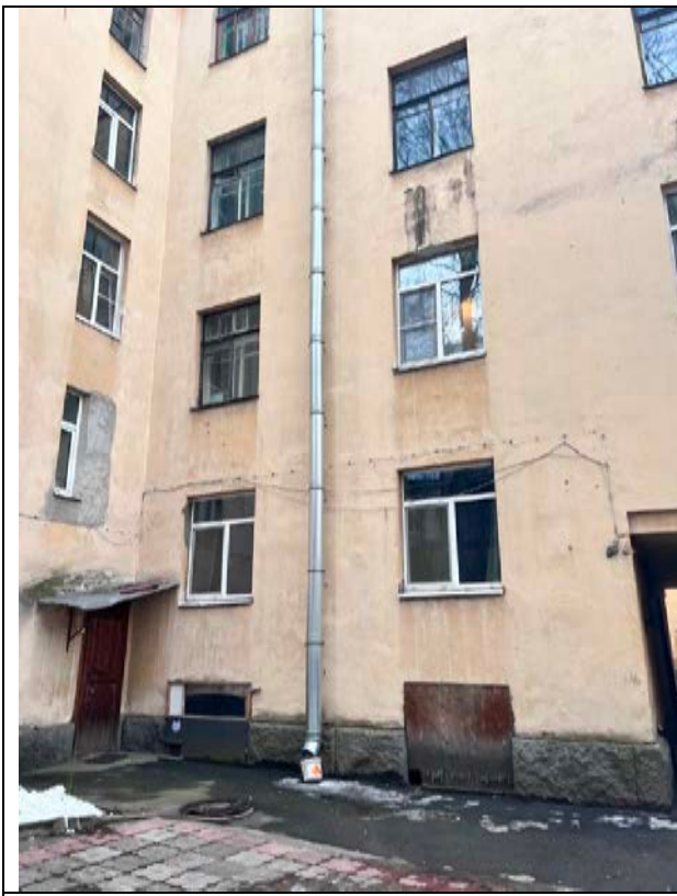
Фото 7. Внутри дворовая территория Объекта оценки
