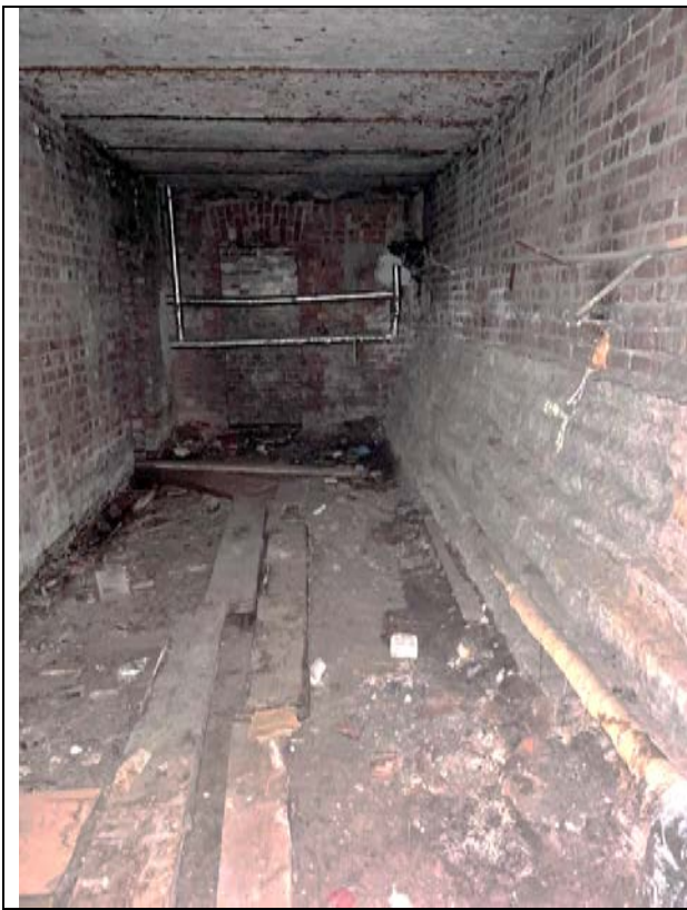
Фото 15. Типичное состояние Объекта оценки
