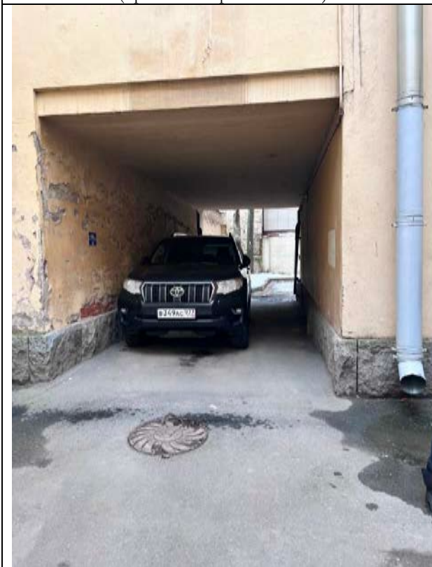
Фото 5. Проход через арку к Объекту оценки
