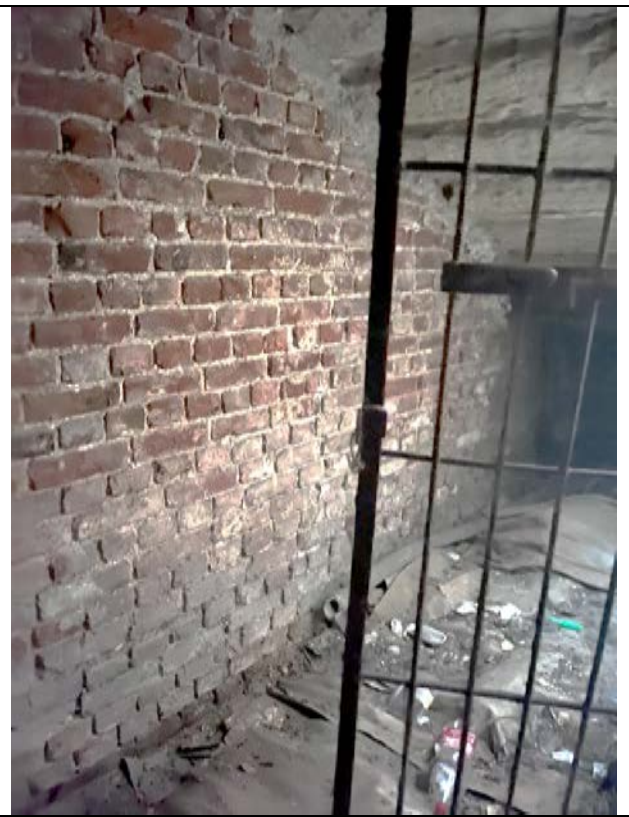
Фото 12. Типичное состояние Объекта оценки
