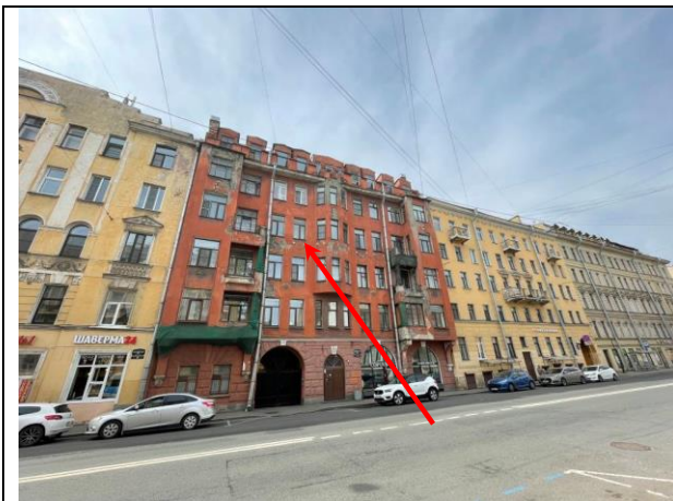
Фото 13. Вид здания расположения Объекта оценки
