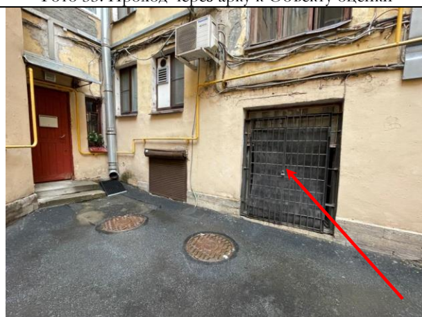
Фото 35. Оконная группа Объекта оценки со стороны двора
