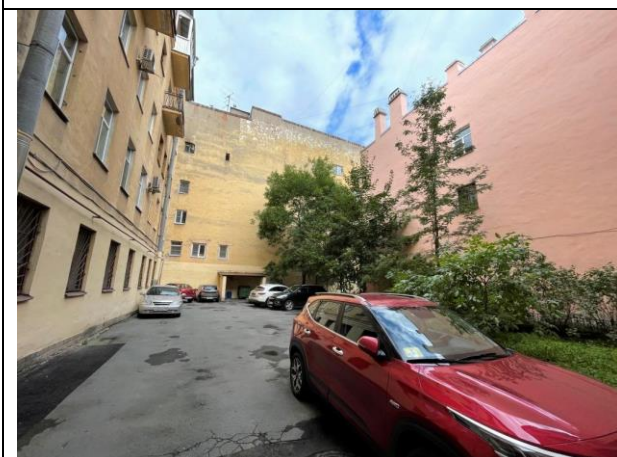
Фото 23. Внутридворовая территория Объекта оценки
