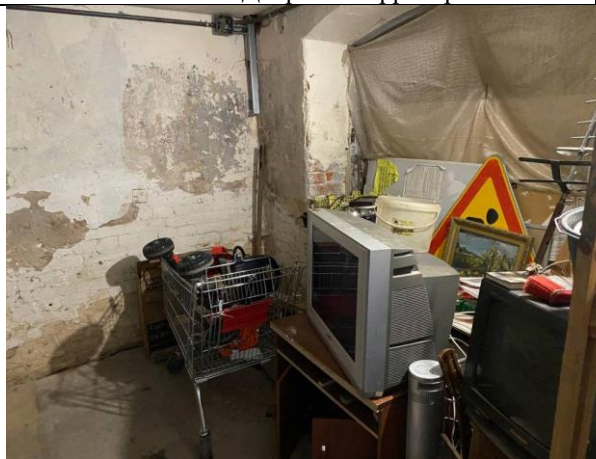
Фото № 7 – Внутреннее состояние помещения
