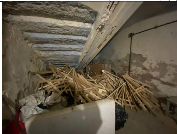
Фото № 8 – Внутреннее состояние помещения
