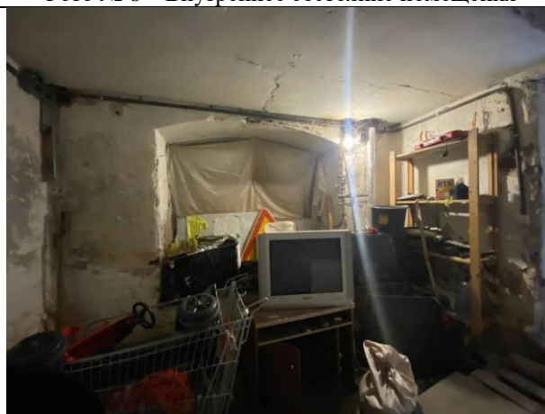
Фото № 10 – Внутреннее состояние помещения
