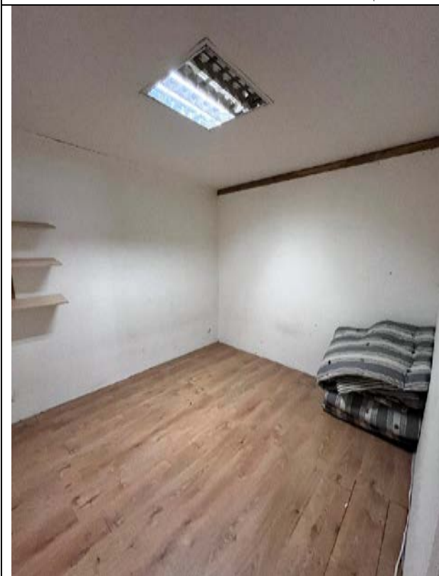
Фото 23. Типичное состояние Объекта оценки
