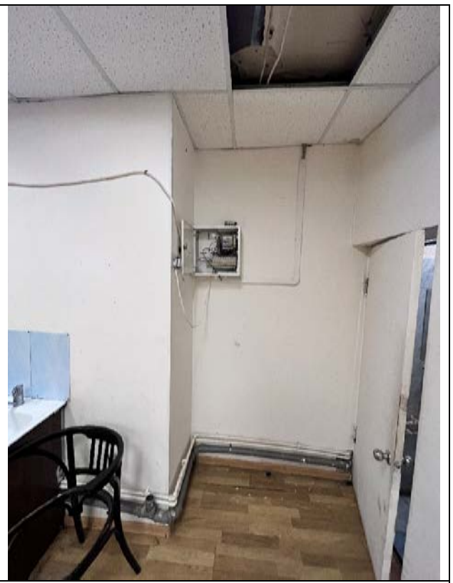
Фото 22. Типичное состояние Объекта оценки
