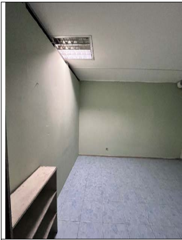
Фото 33. Типичное состояние Объекта оценки
