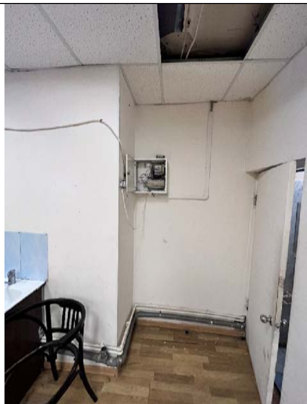
Фото 22. Типичное состояние Объекта оценки
