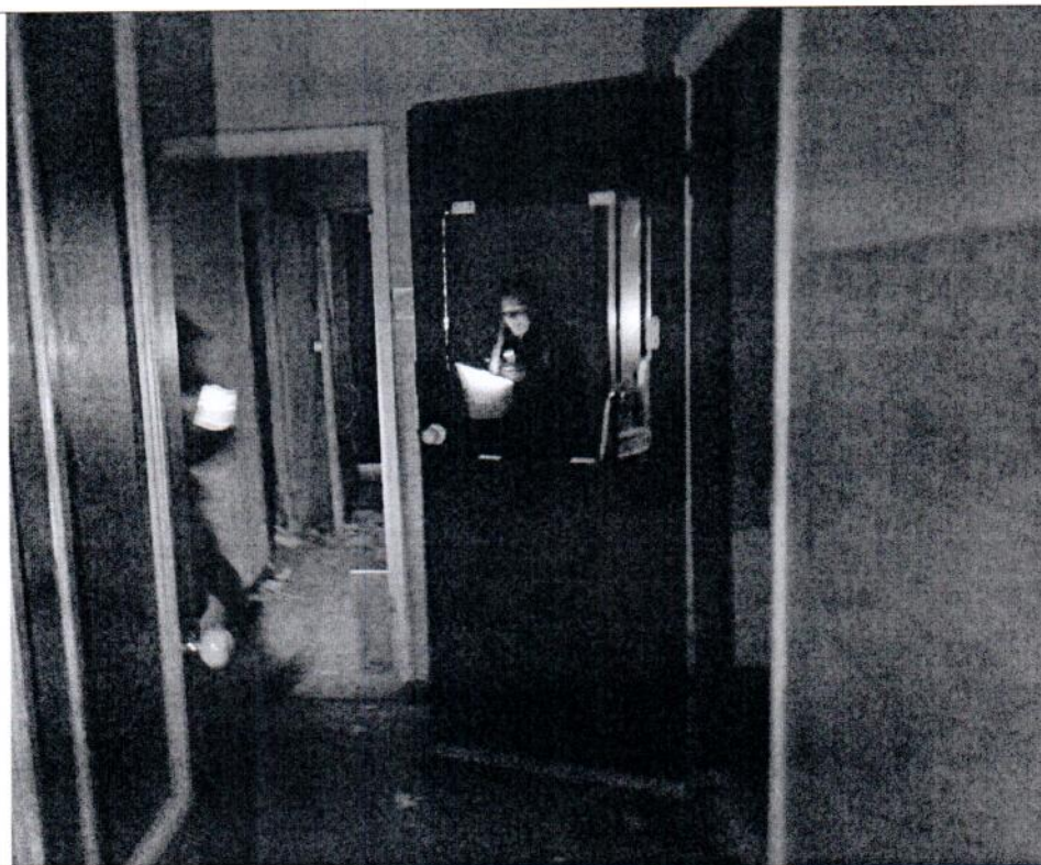
Описание: Установлен дверной проем из ч.п. 1 в ч.п. 7 Объекта.
