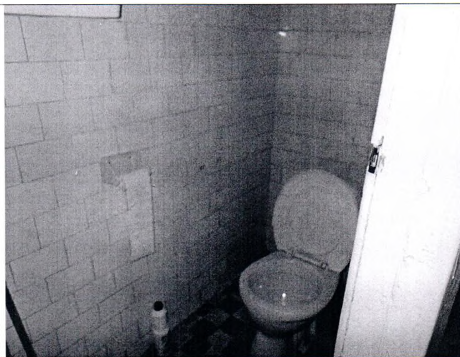
Описание: Вид внутри Объекта
