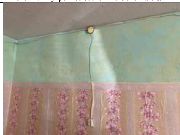
Фото 13. Внутреннее состояние Объекта оценки
