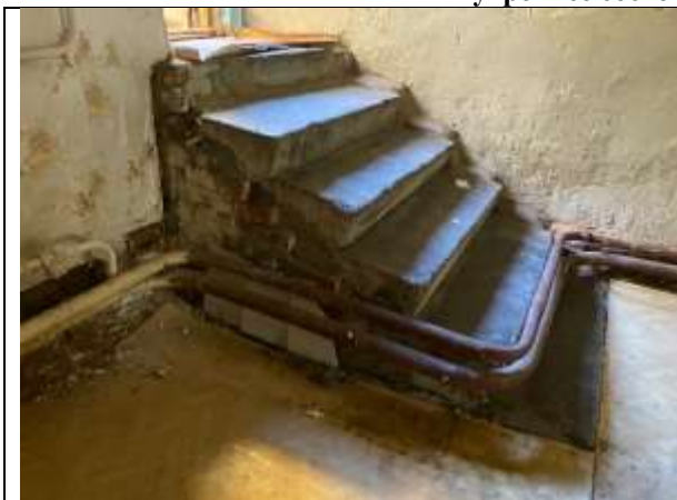
Фото 7. Внутреннее состояние Объекта оценки
