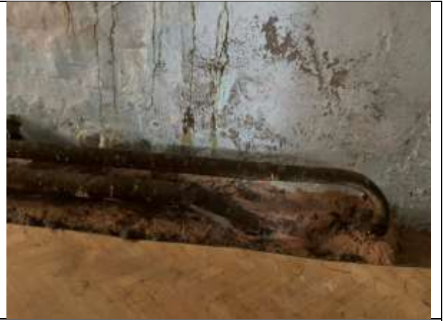
Фото 24. Внутреннее состояние Объекта оценки
