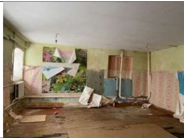
Фото 9. Внутреннее состояние Объекта оценки
