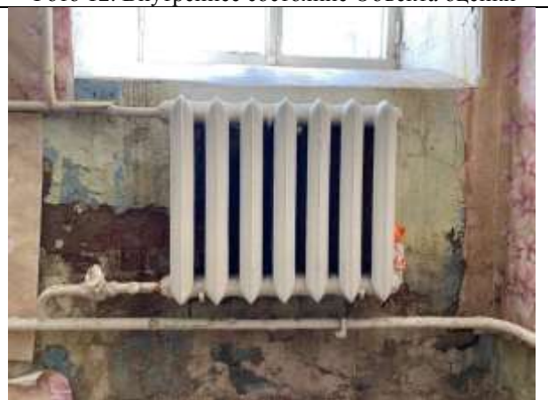
Фото 14. Внутреннее состояние Объекта оценки
