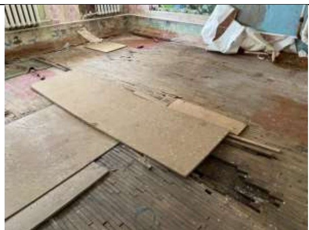
Фото 18. Внутреннее состояние Объекта оценки
