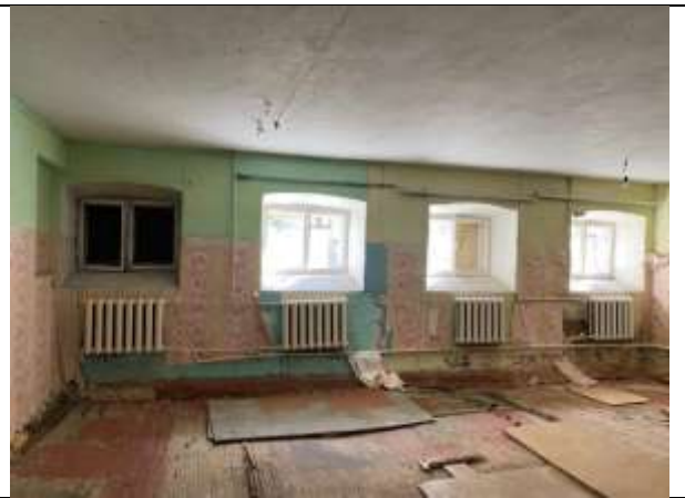
Фото 10. Внутреннее состояние Объекта оценки
