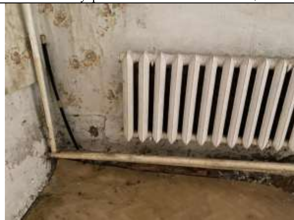
Фото 11. Внутреннее состояние Объекта оценки
