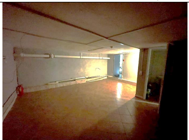
Фото 24. Типичное состояние Объекта оценки
