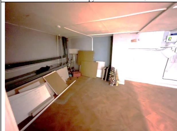
Фото 23. Типичное состояние Объекта оценки
