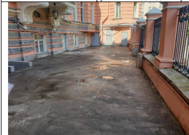
Фото № 3 – Ближайшее окружение и подъездные пути
