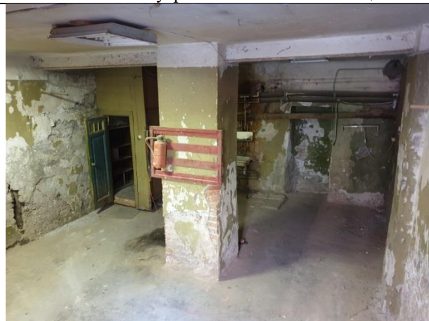
Фото № 20 – Внутреннее состояние помещения
