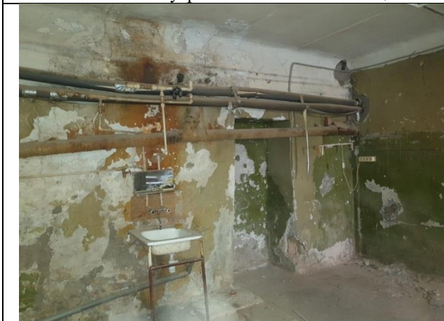
Фото № 19 – Внутреннее состояние помещения
