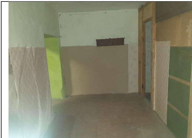
Фото № 17 – Внутреннее состояние помещения
