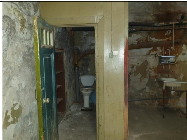
Фото № 18 – Внутреннее состояние помещения
