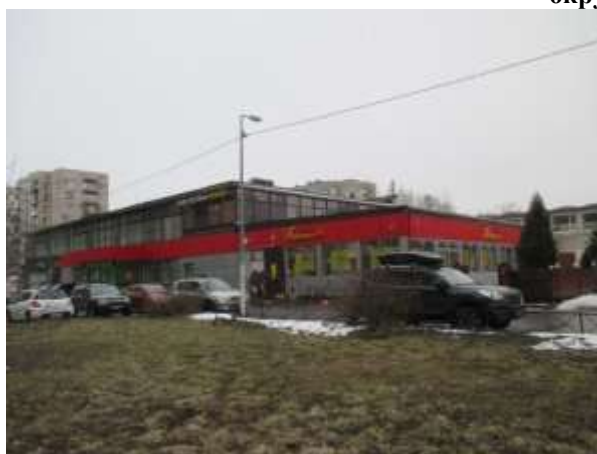
Фото 1. Вид здания, в котором расположен Объект оценки, со двора
