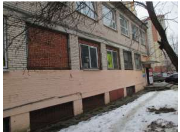
Фото 8. Оконные проемы Объекта
