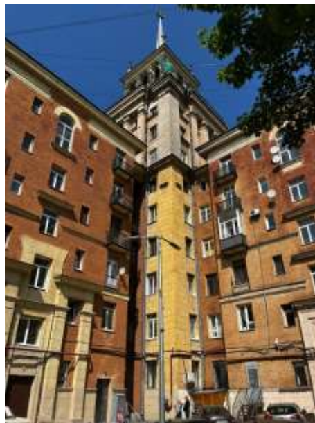
Фото 2. Вид здания Объекта оценки со двора
