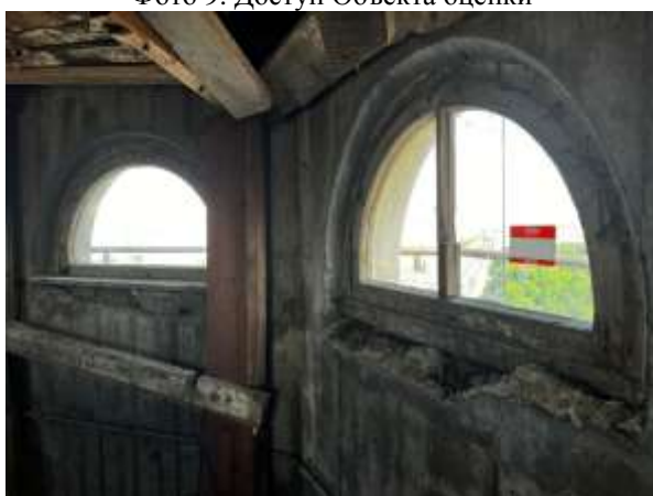
Фото 11. Вид окон Объекта оценки
