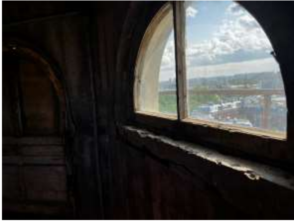
Фото 13. Вид окон Объекта оценки
