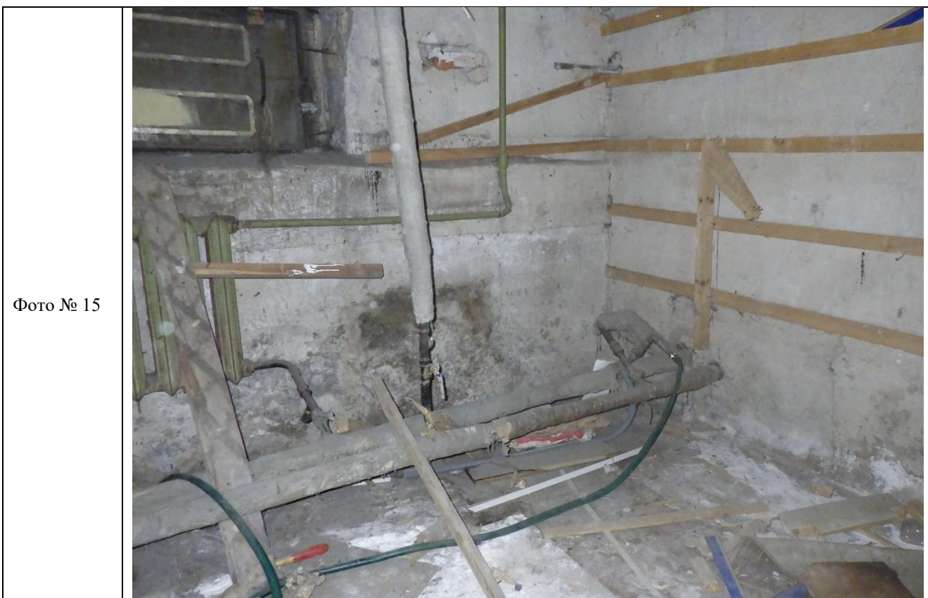
Описание: в ч.п. 12 Объекта транзитом проходят трубы
