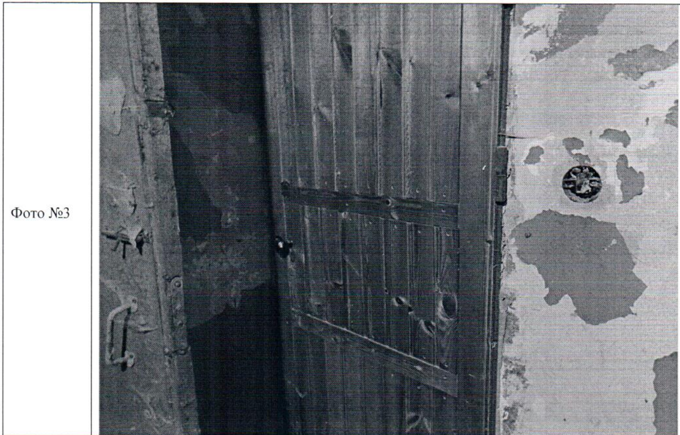
Описание: Вход в Объект со двора (проход через лестничную клетку №2)
