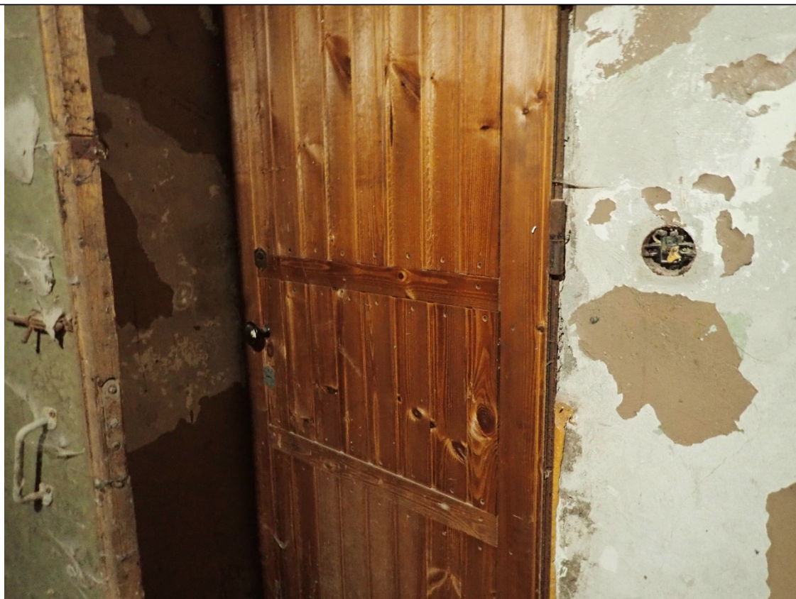
Описание: Вход в Объект со двора (проход через лестничную клетку №2)
