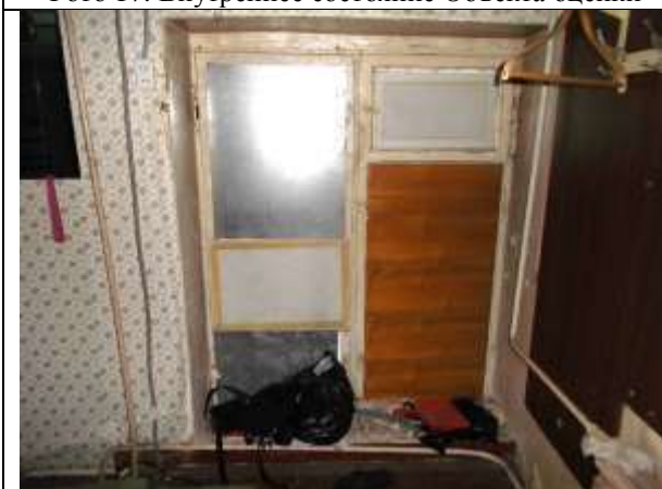
Фото 19. Внутреннее состояние Объекта оценки
