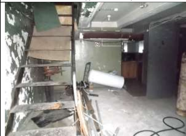
Фото 9. Внутреннее состояние Объекта оценки
