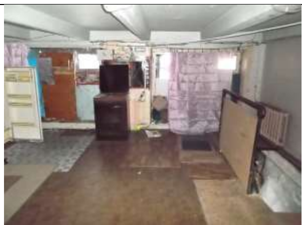
Фото 14. Внутреннее состояние Объекта оценки
