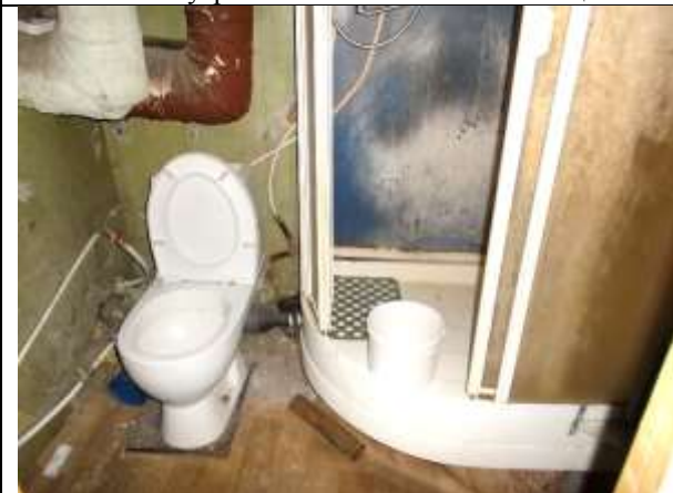
Фото 11. Внутреннее состояние Объекта оценки
