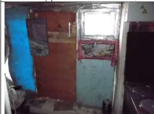
Фото 15. Внутреннее состояние Объекта оценки
