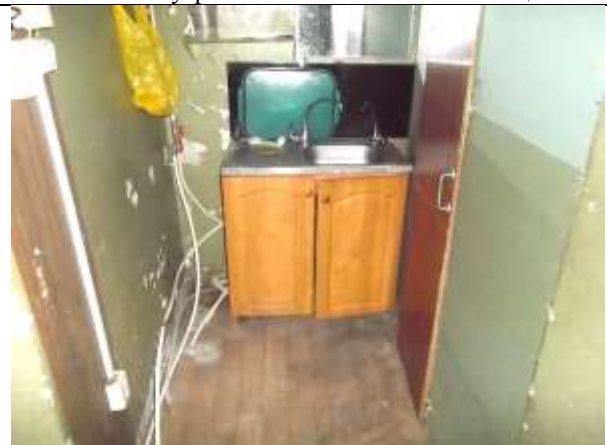
Фото 12. Внутреннее состояние Объекта оценки
