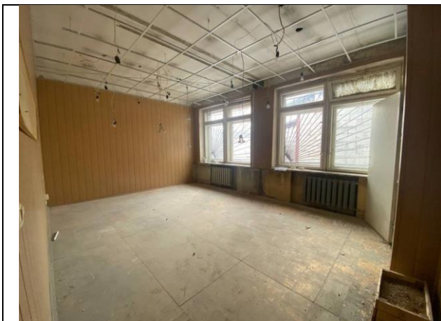
Фото № 9 – Внутреннее состояние помещения
