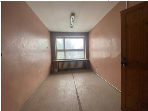
Фото № 7 – Внутреннее состояние помещения
