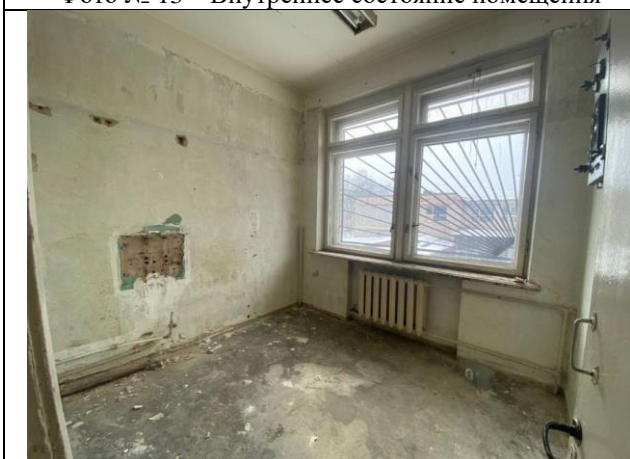
Фото № 15 – Внутреннее состояние помещения
