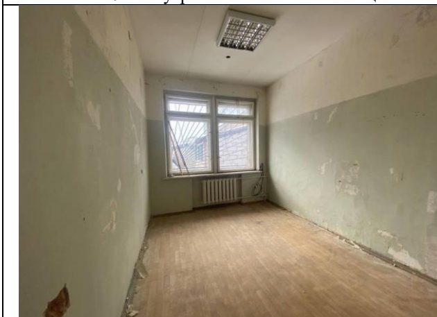
Фото № 11 – Внутреннее состояние помещения
