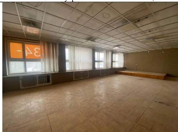
Фото № 12 – Внутреннее состояние помещения
