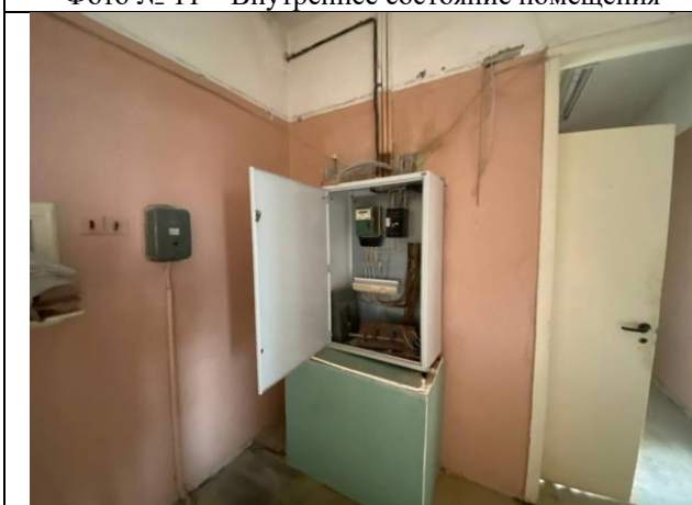
Фото № 13 – Внутреннее состояние помещения
