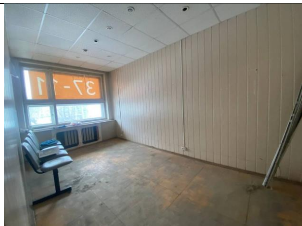
Фото № 10 – Внутреннее состояние помещения
