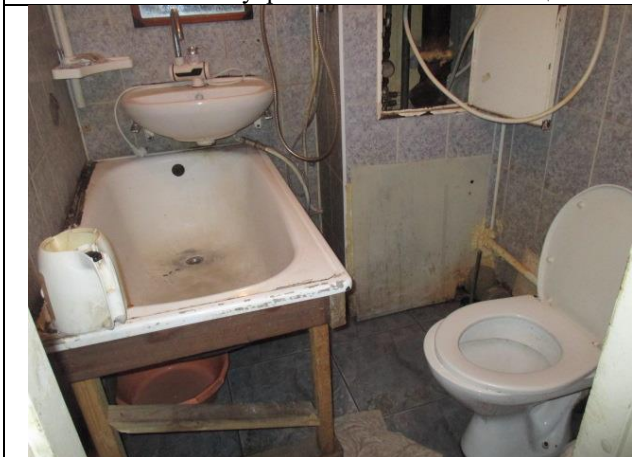
Фото № 13 – Внутреннее состояние помещения
