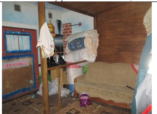
Фото № 24 – Внутреннее состояние помещения
