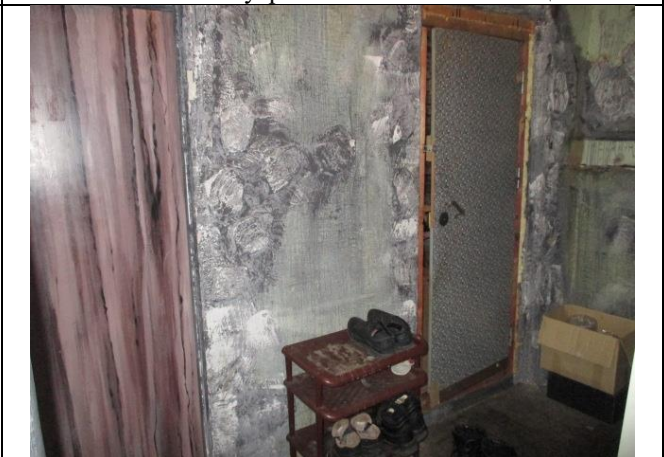
Фото № 14 – Внутреннее состояние помещения
