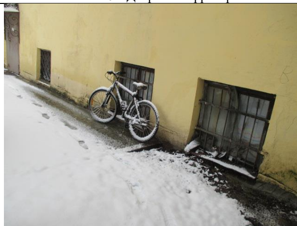
Фото № 8 – Расположение окон помещения
