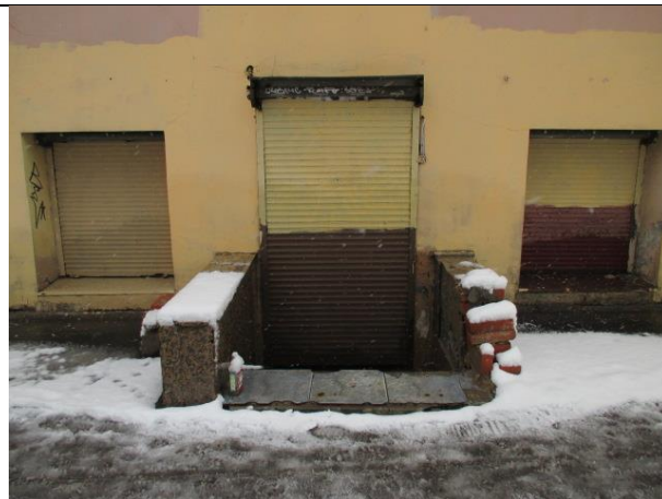
Фото № 4 – Вход в помещение
