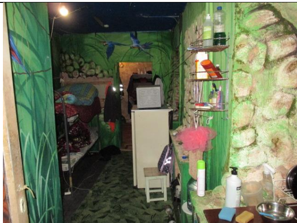
Фото № 28 – Внутреннее состояние помещения
