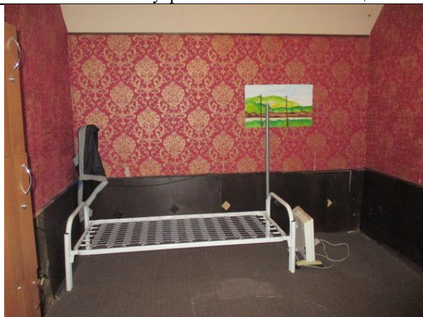
Фото № 25 – Внутреннее состояние помещения
