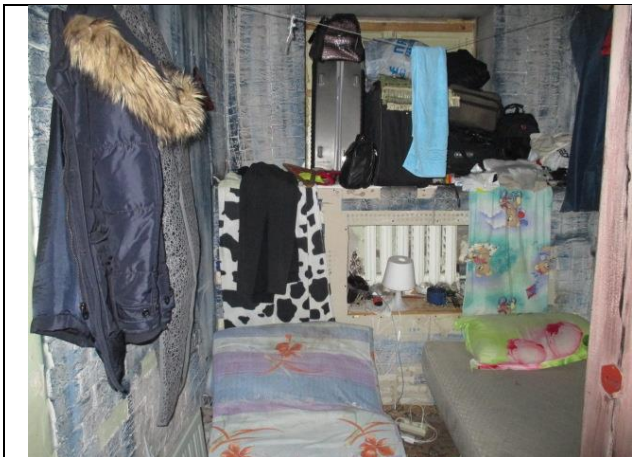
Фото № 19 – Внутреннее состояние помещения
