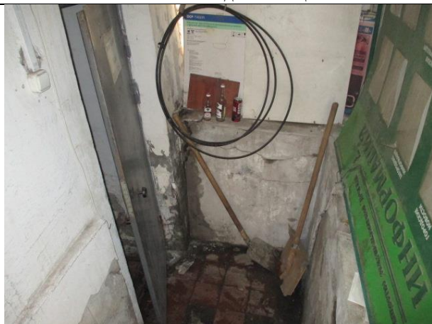
Фото № 9 – Внутреннее состояние помещения
