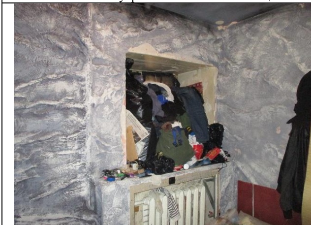
Фото № 17 – Внутреннее состояние помещения
