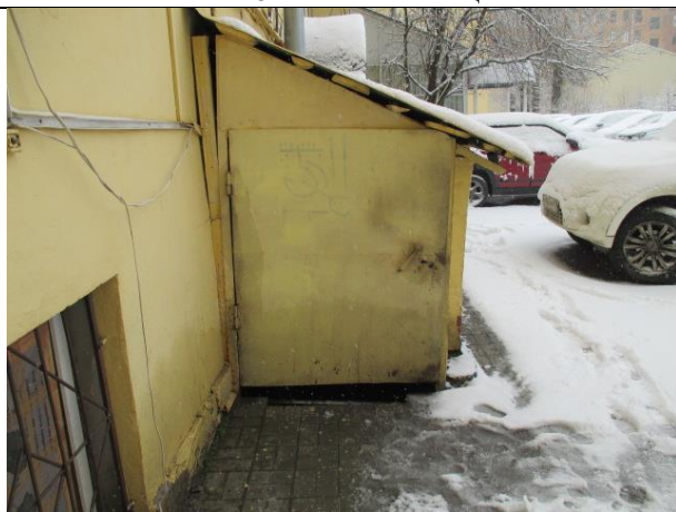
Фото № 7 – Вход в помещение
