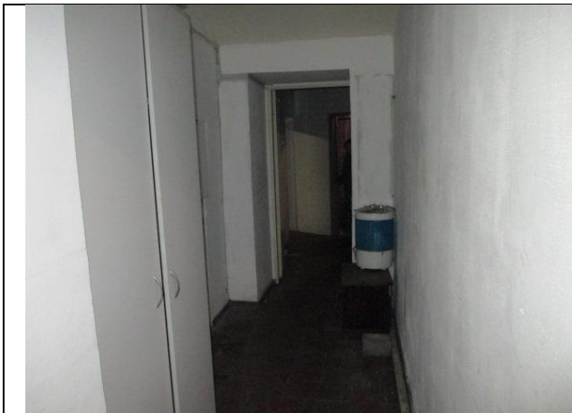
Фото № 11 – Внутреннее состояние помещения
