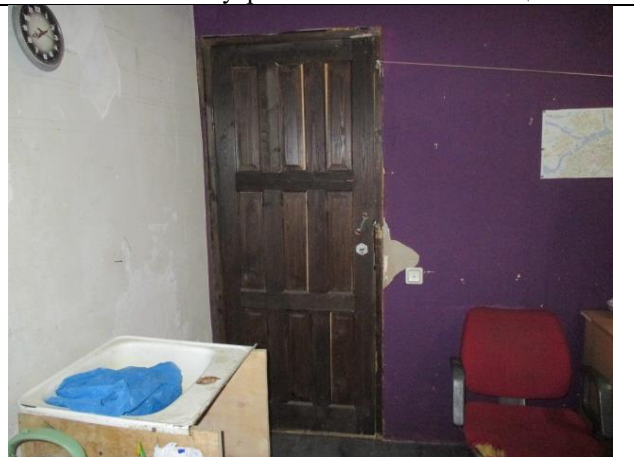
Фото № 22 – Внутреннее состояние помещения
