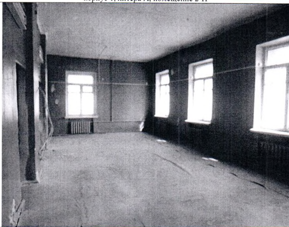
Описание: Вид внутри Объекта
