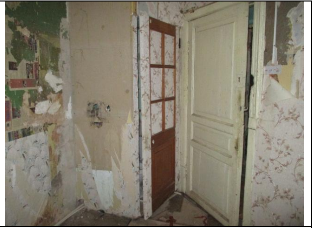
Фото 14. Внутреннее состояние Объекта оценки
