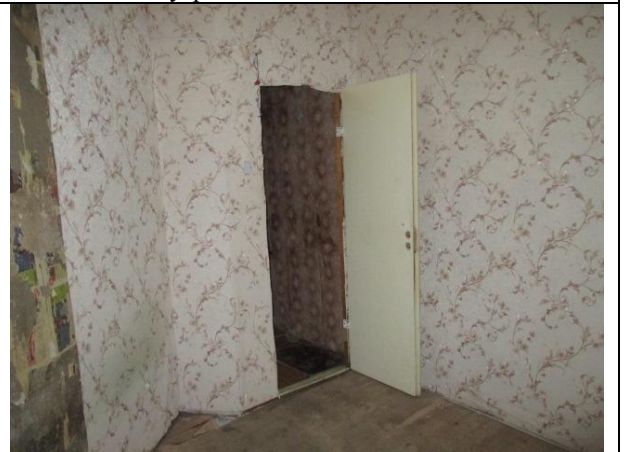
Фото 16. Внутреннее состояние Объекта оценки
