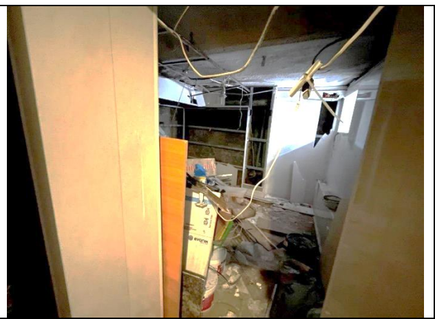
Фото 28. Типичное состояние Объекта оценки
