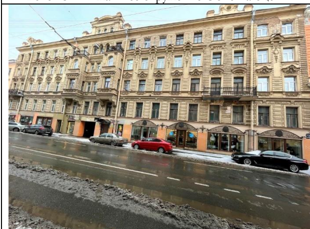
Фото 15. Вид здания расположения Объекта оценки
