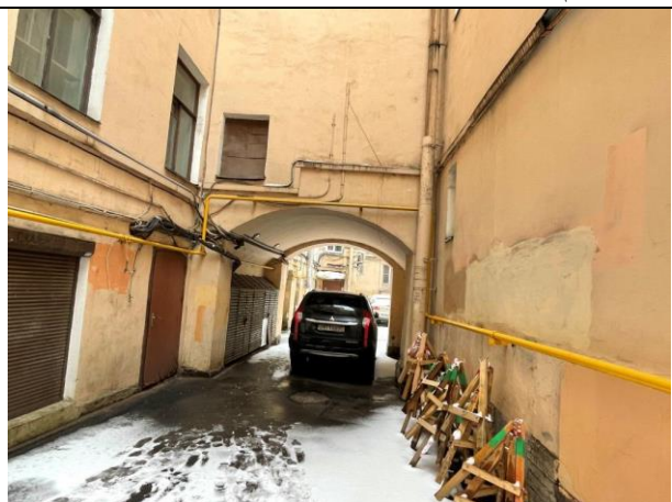
Фото 30. Внутридворовая территория здания расположения Объекта оценки
