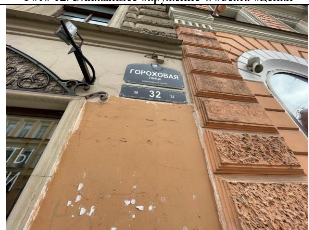
Фото 14. Адрес объекта оценки
