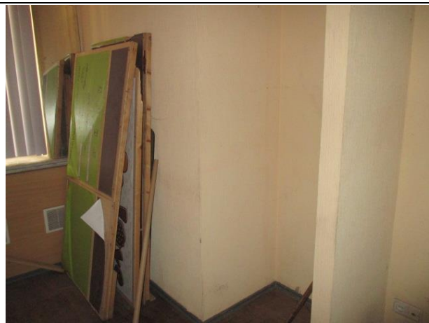
Фото № 19. Внутреннее состояние помещения
