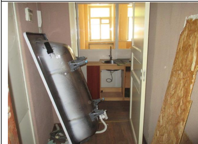
Фото № 11. Внутреннее состояние помещения
