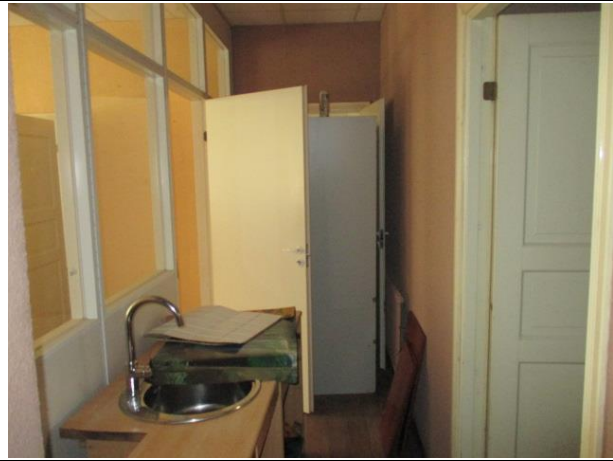
Фото № 13. Внутреннее состояние помещения
