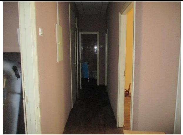
Фото № 16. Внутреннее состояние помещения
