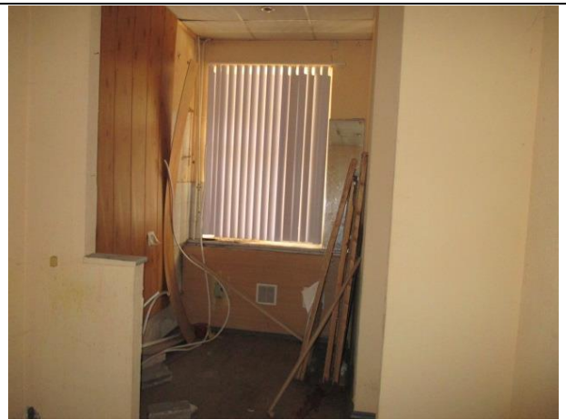
Фото № 18. Внутреннее состояние помещения
