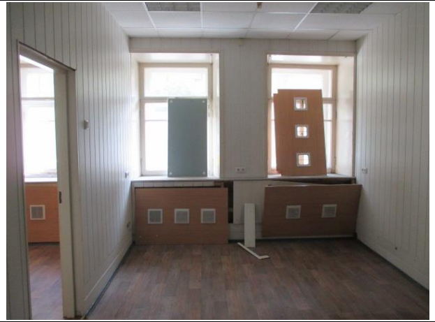
Фото № 14. Внутреннее состояние помещения
