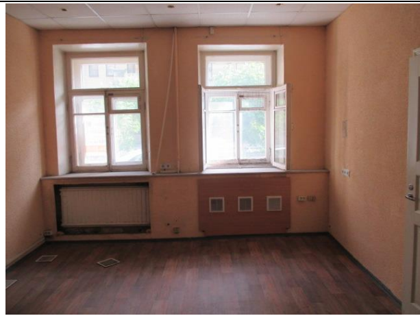
Фото № 15. Внутреннее состояние помещения
