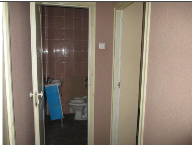
Фото № 17. Внутреннее состояние помещения
