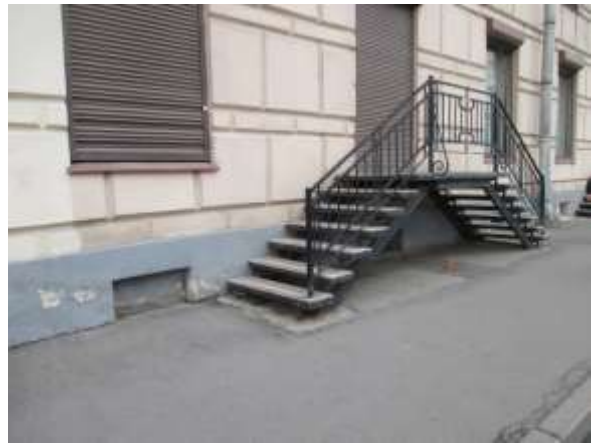
Фото 12. Вид окон Объекта оценки
