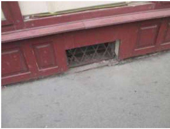
Фото 11. Вид окон Объекта оценки
