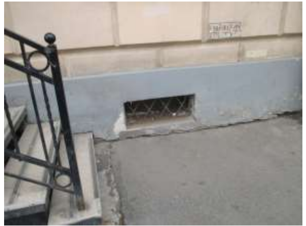
Фото 14. Вид окон Объекта оценки
