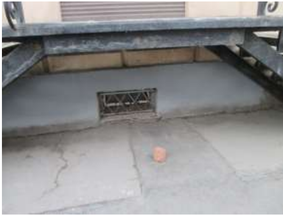
Фото 13. Вид окон Объекта оценки
