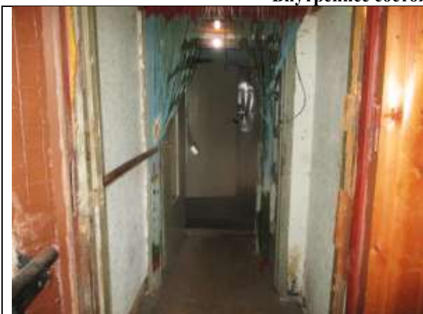
Фото 9. Внутреннее состояние Объекта оценки
