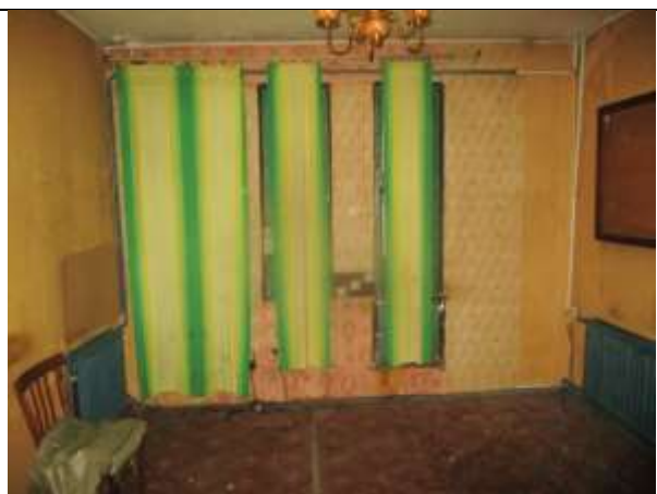
Фото 20. Внутреннее состояние Объекта оценки
