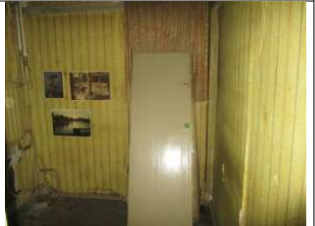
Фото 14. Внутреннее состояние Объекта оценки
