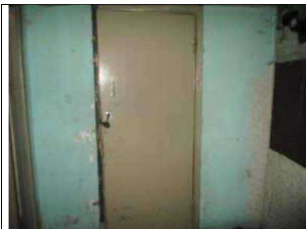
Фото 19. Внутреннее состояние Объекта оценки
