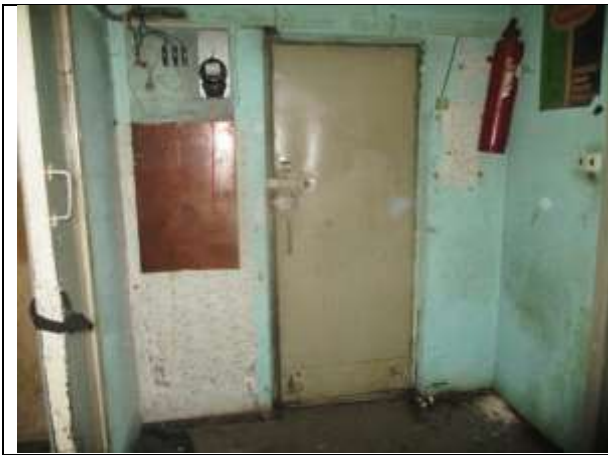
Фото 11. Внутреннее состояние Объекта оценки
