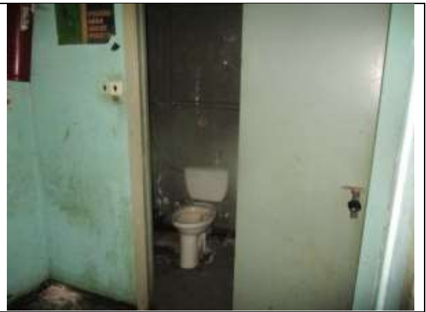
Фото 12. Внутреннее состояние Объекта оценки
