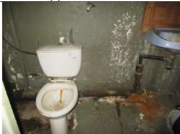
Фото 17. Внутреннее состояние Объекта оценки
