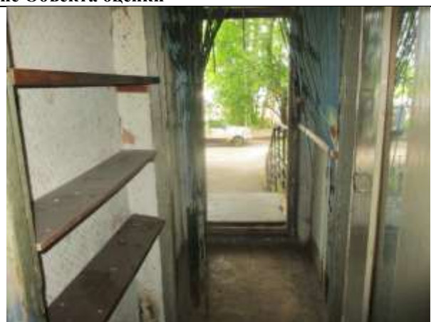
Фото 10. Внутреннее состояние Объекта оценки
