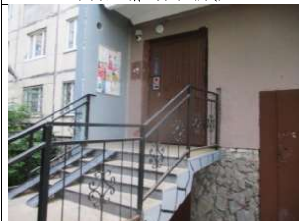
Фото 7. Общий вход Объекта оценки со двора
