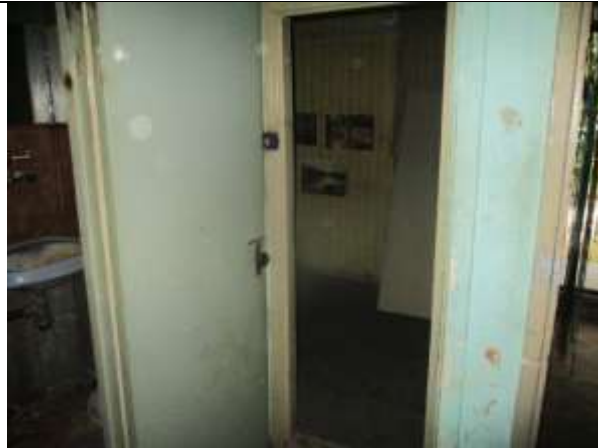
Фото 13. Внутреннее состояние Объекта оценки
