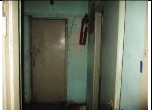
Фото 16. Внутреннее состояние Объекта оценки
