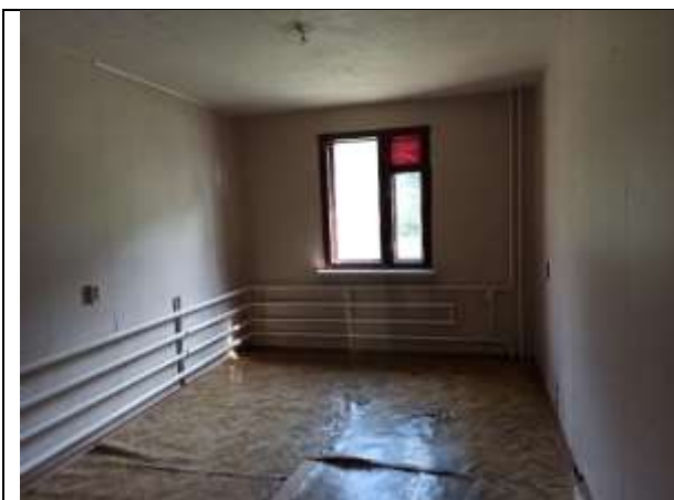
Фото 13. Внутреннее состояние Объекта оценки
