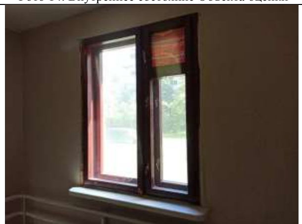
Фото 16. Внутреннее состояние Объекта оценки
