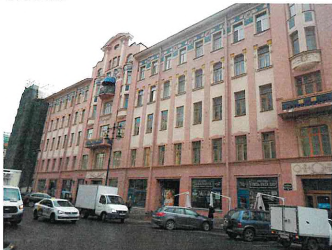
Фото №3 (общий вход в помещение)
