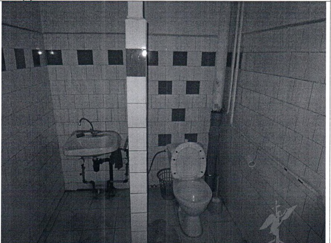
Описание: вид внутри ч.п. 5 помещения 13-Н Объекта
