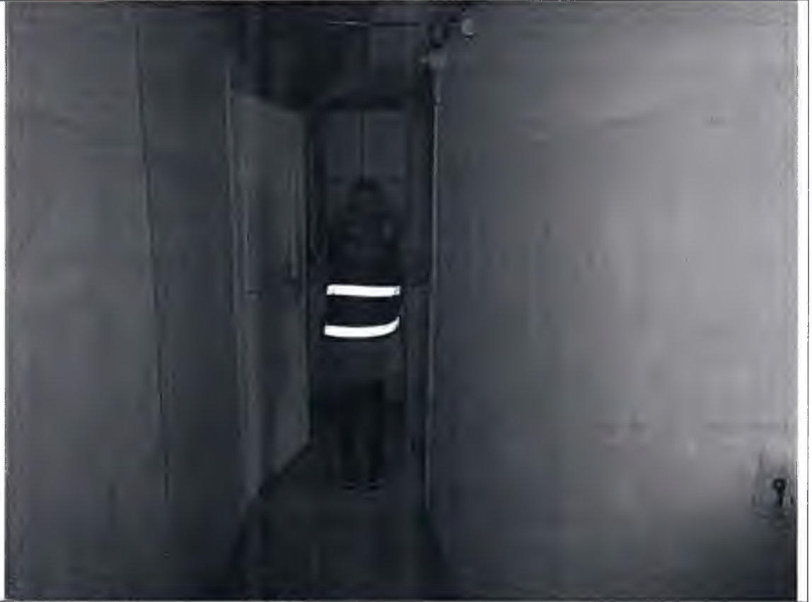
Описание: вид внутри ч.п. 3 помещения 13-Н Объекта
