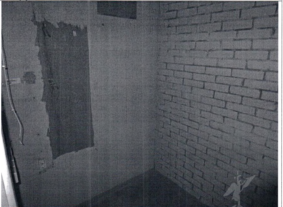
Описание: вид внутри ч.п. 2 помещения 13-Н Объекта
