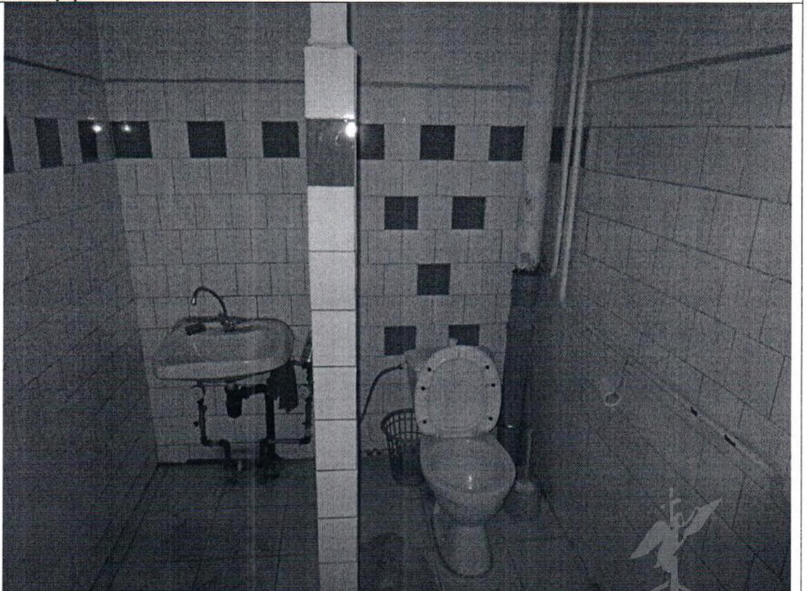
Описание: вид внутри ч.п. 5 помещения 13-Н Объекта
