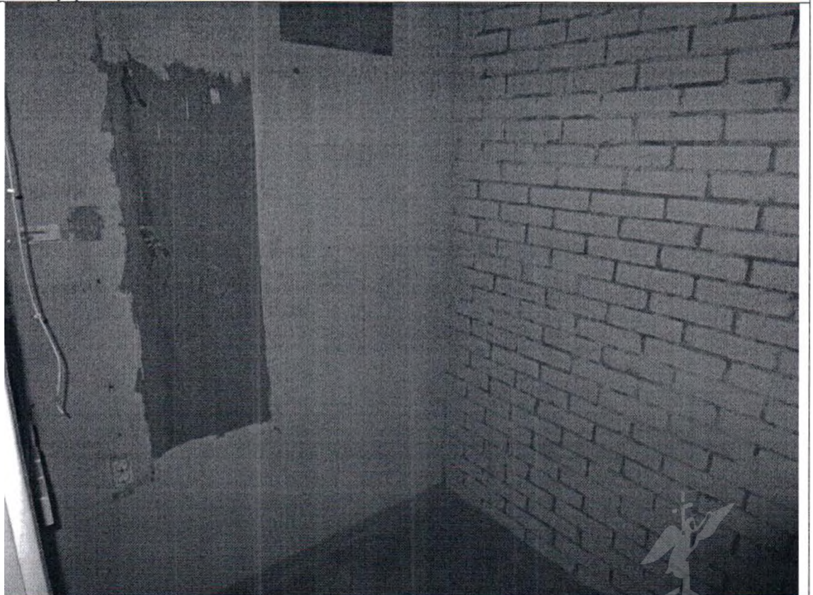
Описание: вид внутри ч.п. 2 помещения 13-Н Объекта
