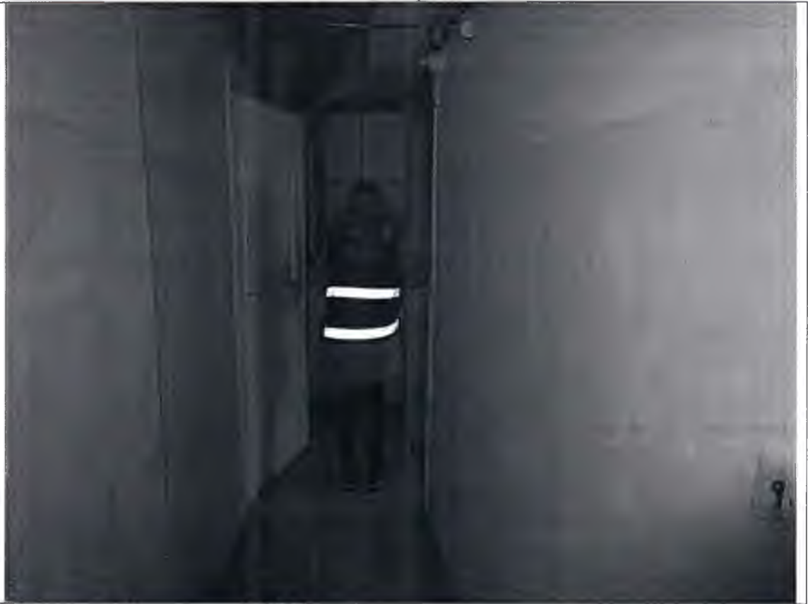
Описание: вид внутри ч.п. 3 помещения 13-Н Объекта
