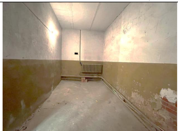
Фото 24. Типичное состояние Объекта оценки
