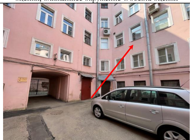
Фото 26. Вид здания расположения Объекта оценки
