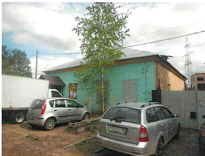
Фото №3 (вход в помещение)
