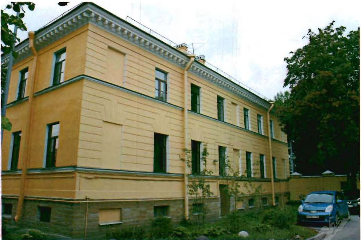
Фото №10. Вид на восточный фасад со стороны внутреннего двора.
