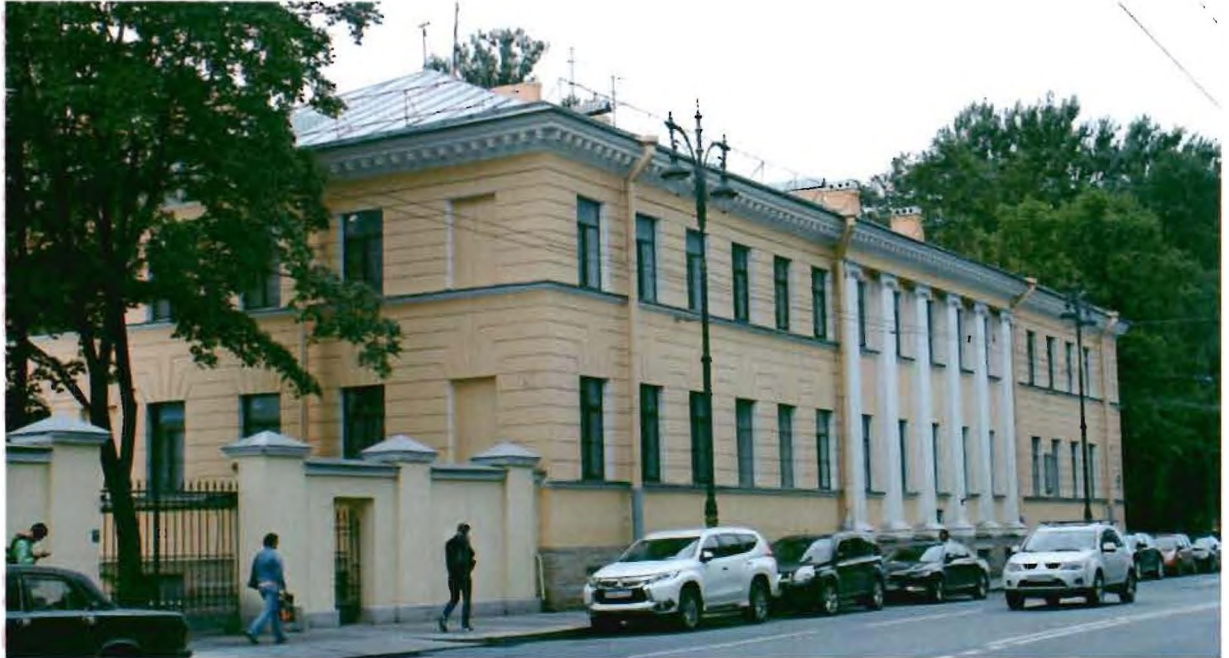
Фото №9. Вид на северный фасад со стороны ул. Кирочной.
