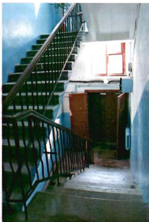
Фото №16. Боковая (восточная) межэтажная лестница.
