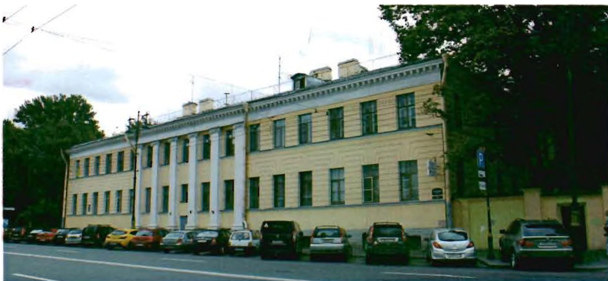
Фото №1. Вид на северный фасад со стороны ул. Кирочной.
