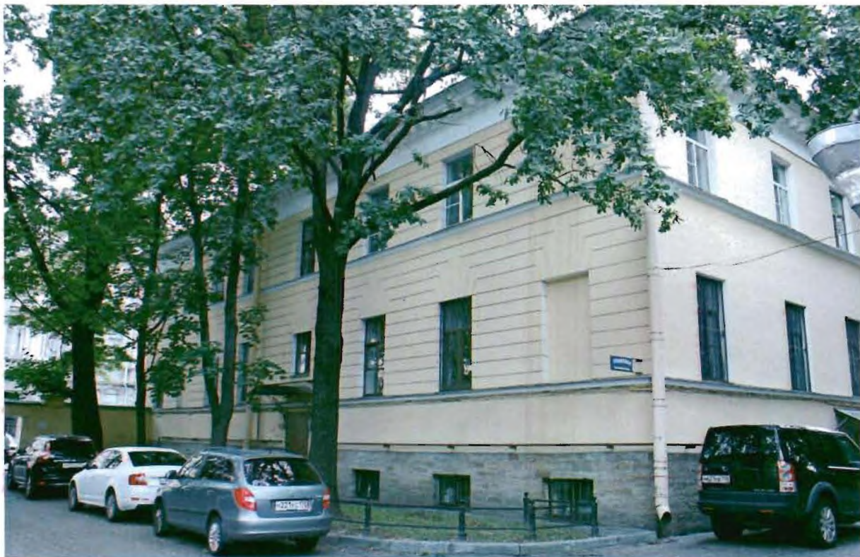
Фото №3. Вид на западный фасад со стороны внутреннего двора.
