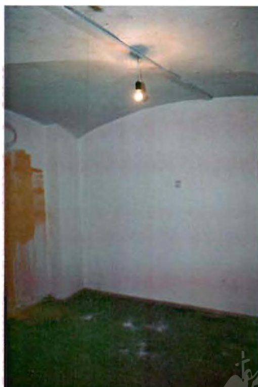
Фото №17. Помещение цокольного этажа.
