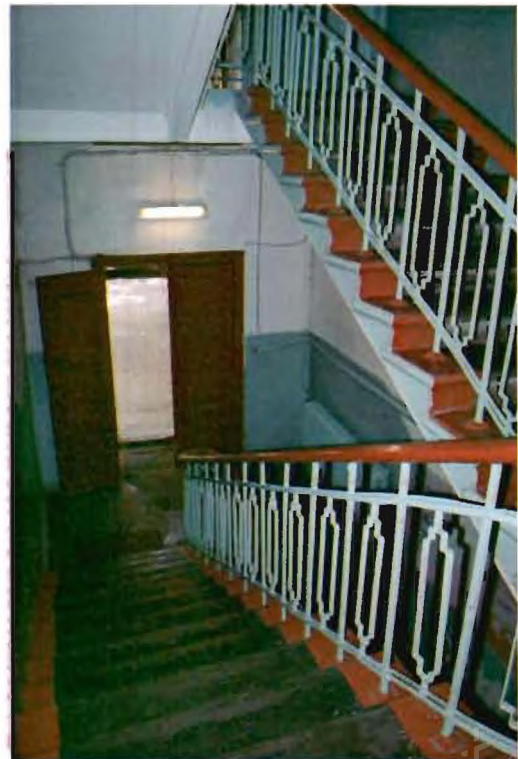
Фото №8. Боковая (западная) межэтажная лестница
