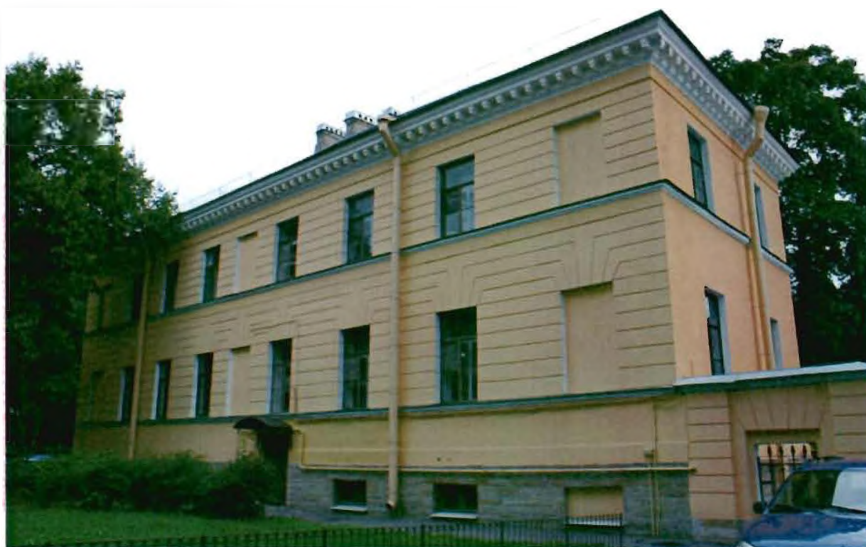
Фото №11. Вид на западный фасад со стороны сада.
