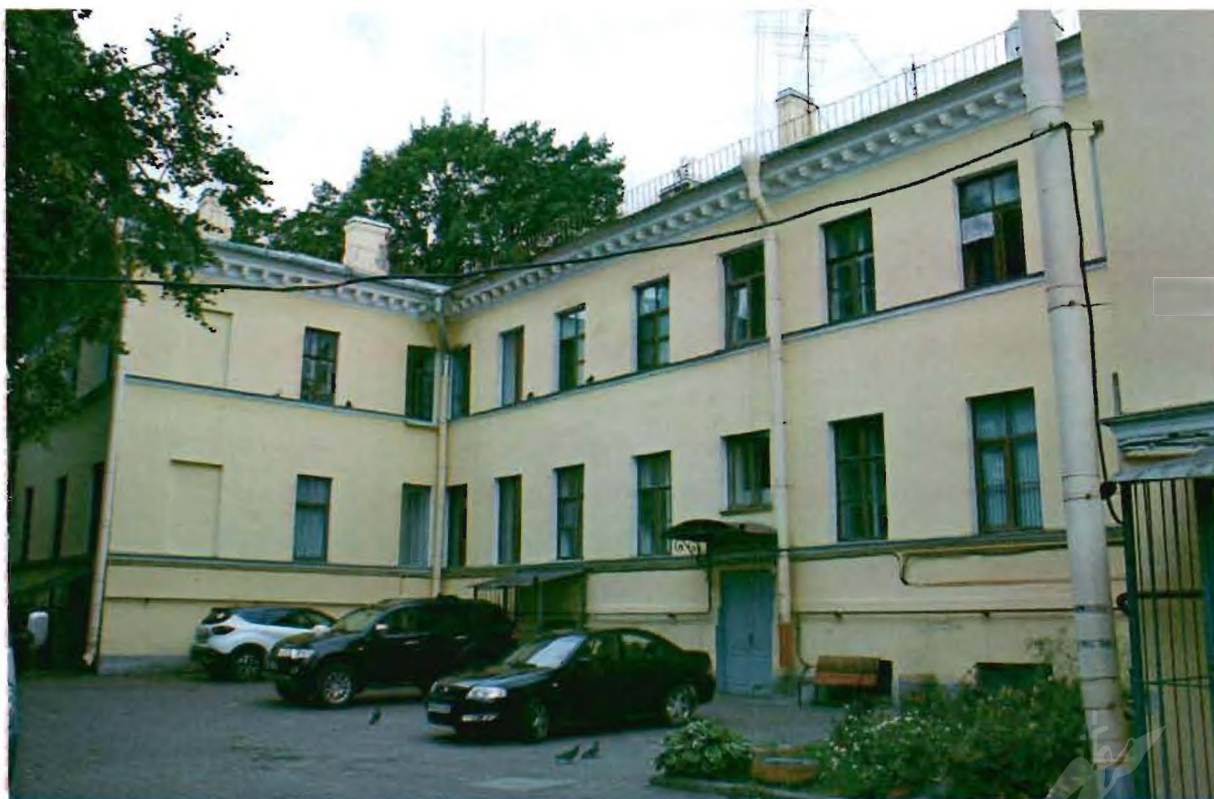
Фото №4. Вид на южные фасады со стороны внутреннего двора.
