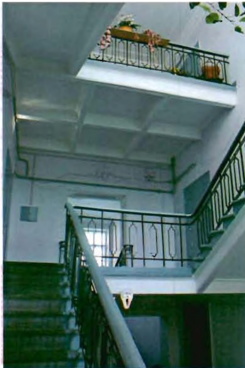
Фото №7. Центральная межэтажная лестница.
