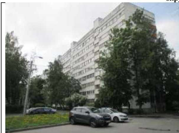
Фото 1. Вид здания, в котором расположен Объект оценки
