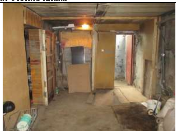
Фото 8. Внутреннее состояние Объекта оценки
