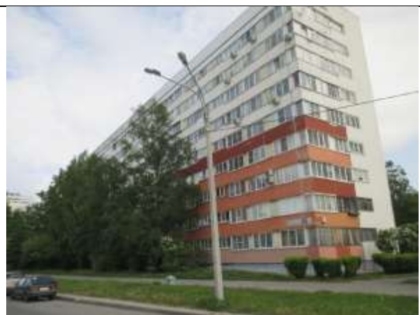
Фото 4. Вид здания, в котором расположен Объект оценки. Ближайшее окружение
