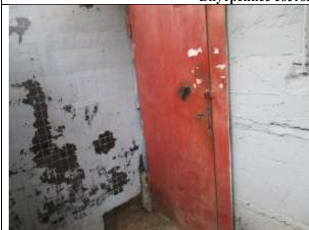
Фото 7. Вход Объекта оценки
