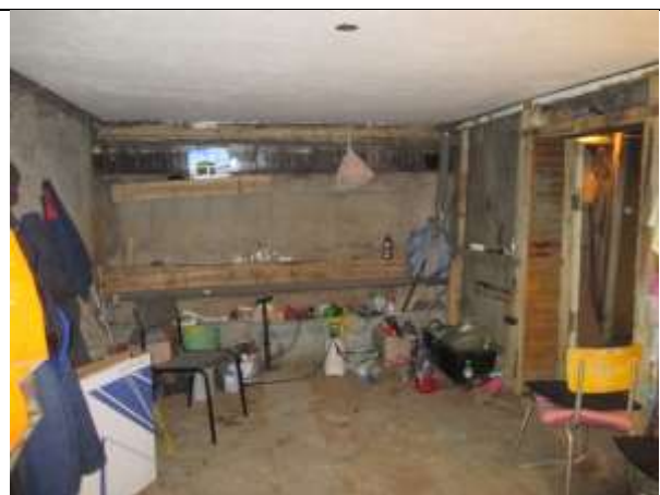
Фото 10. Внутреннее состояние Объекта оценки
