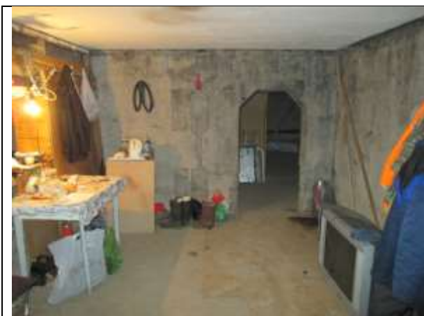
Фото 9. Внутреннее состояние Объекта оценки
