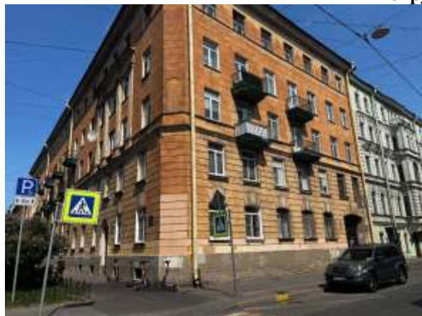
Фото 1. Вид здания Объекта оценки
