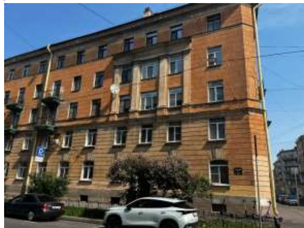
Фото 2. Вид здания Объекта оценки
