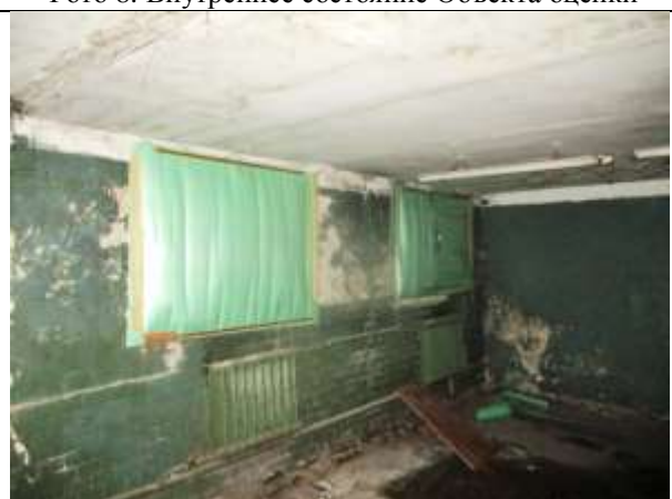
Фото 10. Внутреннее состояние Объекта оценки
