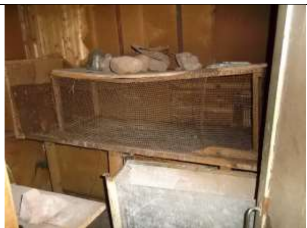
Фото 14. Внутреннее состояние Объекта оценки
