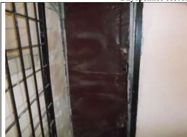
Фото 7. Внутреннее состояние Объекта оценки
