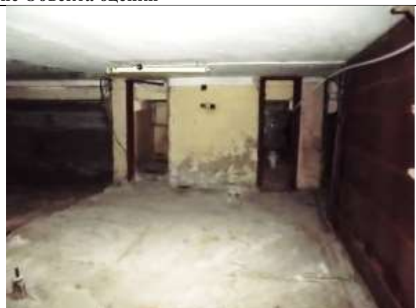
Фото 8. Внутреннее состояние Объекта оценки
