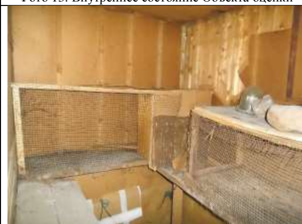
Фото 15. Внутреннее состояние Объекта оценки
